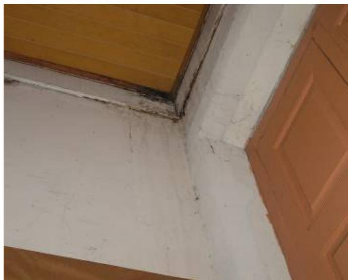
**Imagem 32:** Infiltração, Goteiras e Mofo
