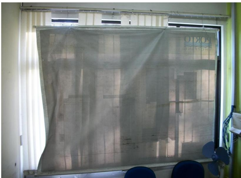
Figura 67 – Janela da Sala 1 mostrando a persiana em péssimo estado de conservação, assim como um bloqueio improvisado de lona
