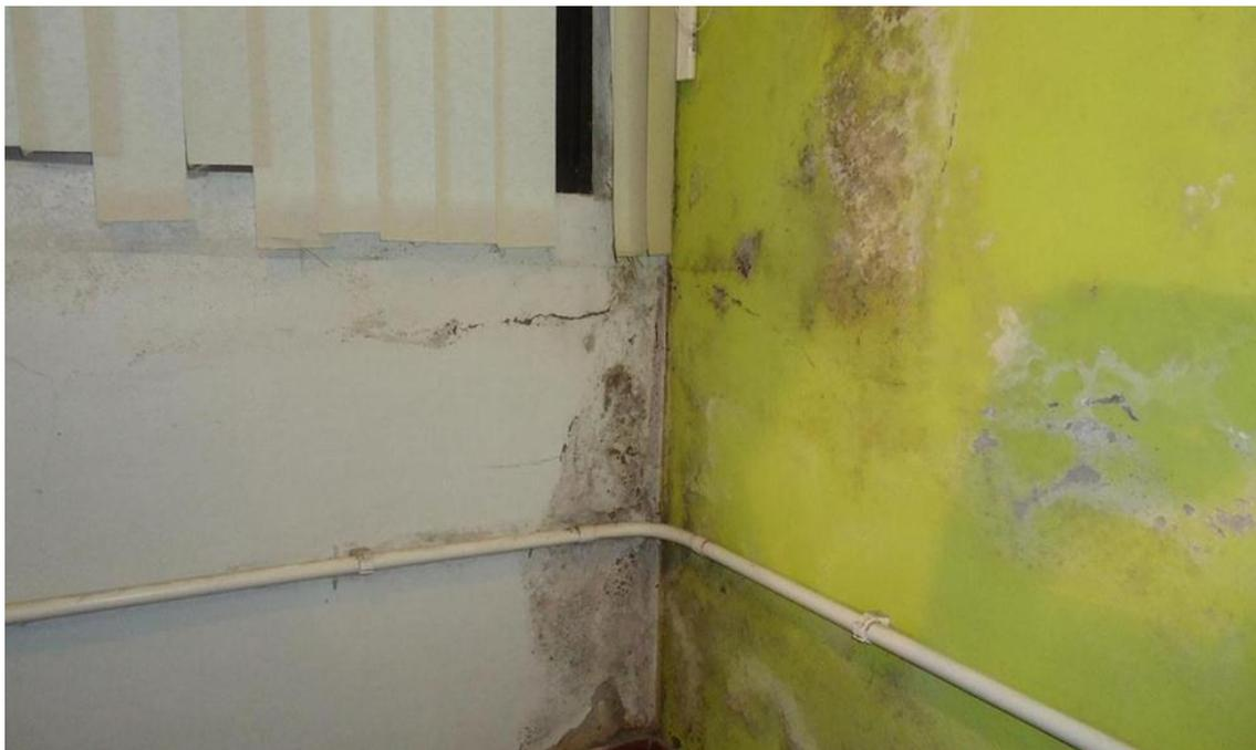
Figura 54 – Vista parcial de uma das paredes da Sala 2 com infiltração, consequentemente fungos e pequenos desprendimentos na camada de reboco, tudo muito próximo a instalações elétricas
