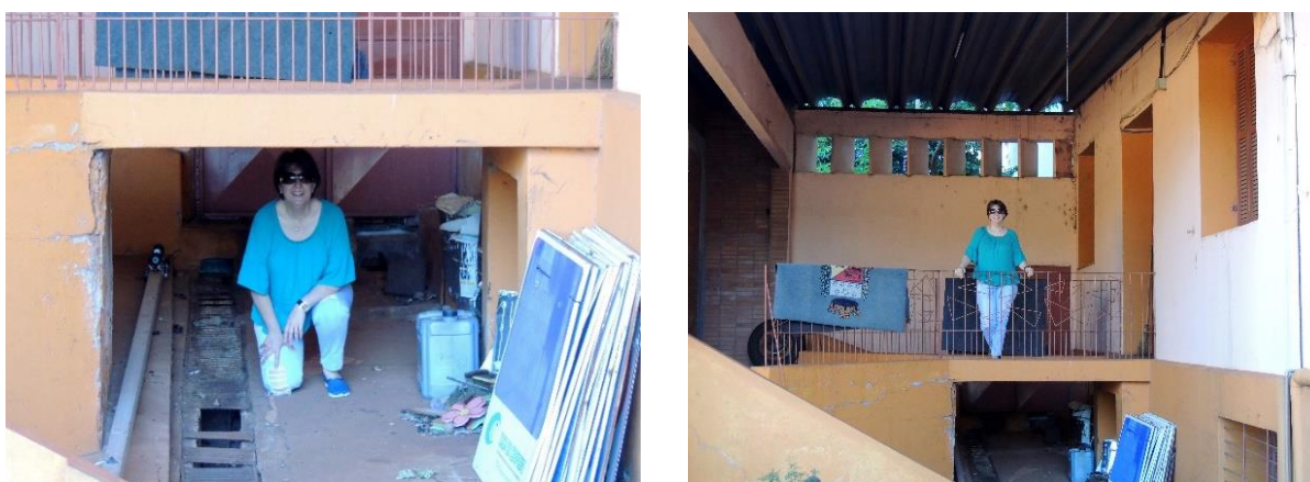
Figura 09: Aspectos do pátio interno do atual Centro Administrativo, antiga Escola, Giruá/RS.
