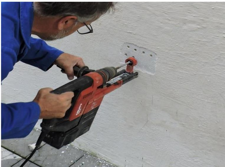
Figura 29. Retirada de amostras na fachada leste - Local L1.
