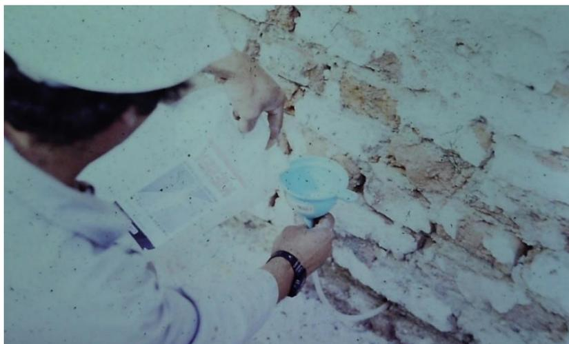
Figura 15. Imagem do corte hídrico executado nas alvenarias da Catedral de São Pedro.
