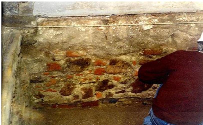
Figura 15. Umidade identificada nas fundações na fase de diagnóstico.
