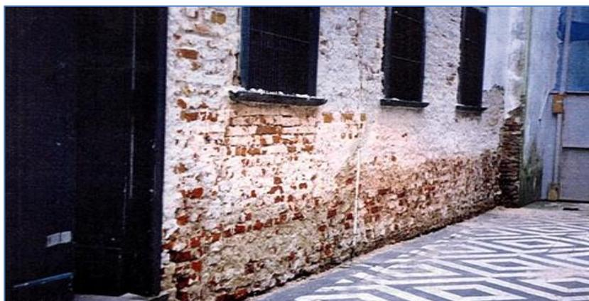
Figura 133. Parede com presença de umidade ascendente na fachada leste.
