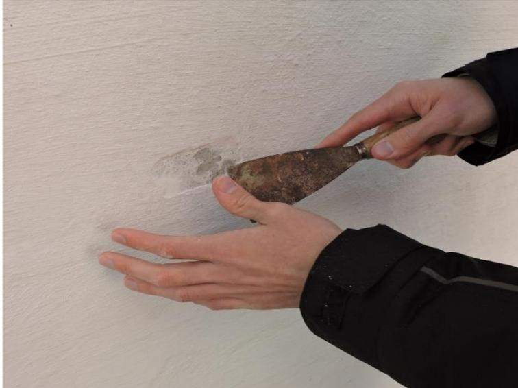
Figura 228. Remoção da camada de pintura no local de coleta das amostras.
