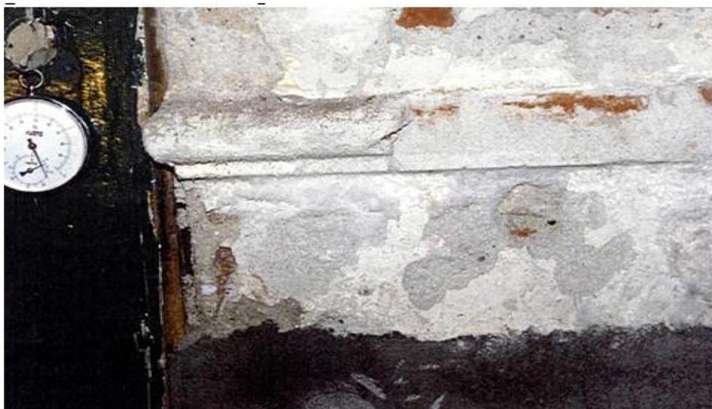
Figura 9. Medição com um termo-higrômetro das condições ambientais no interior da Catedral de São Pedro.
