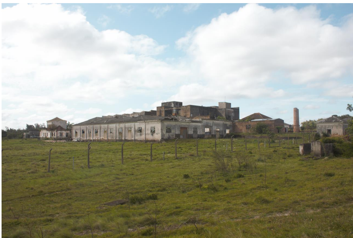
Figura 39. Estruturas no terreno. Vista Lateral. Fotografia da autora, 2020.
