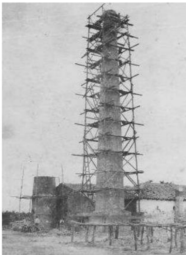
Figura 7. Construção da Chaminé da Charqueada União. Fonte: Intendência Municipal, 1912.
