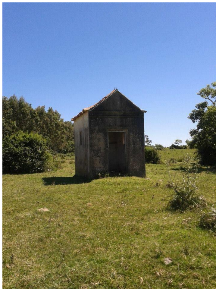
Figura 28. Estruturas em ruínas às margens do rio Jaguarão. Foto da autora, 2016.
