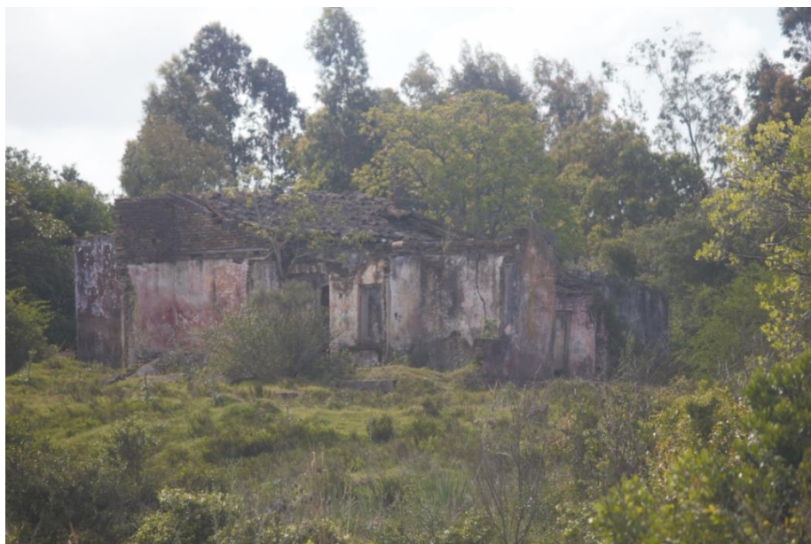
Figura 27. Estruturas em ruínas às margens do rio Jaguarão. Foto da autora, 2016.
