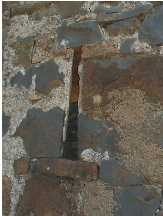
Figura 18. Detalhe da abertura vertical na construção em pedra para a vigia da propriedade
