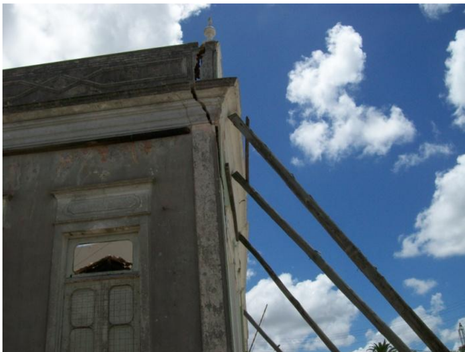
Figura 29 – Fachada do Clube Jaguareense apoiada pela cimbalha. Fonte: A Autora, dezembro de 2011.
