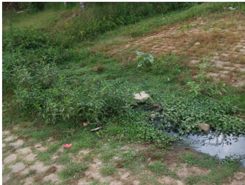
Figura 30 - Esgoto sem duto de canalização, bairro Cerro da Pólvora. Fonte: A Autora, dezembro de 2011.
