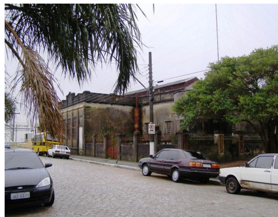
Figura 42 - Usina Elétrica de Jaguarão desativada. Fonte: Autor Lino Corrêa, março de 2009.
