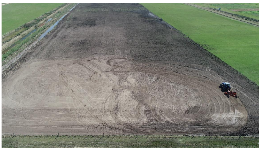
Figura 2: Operação de sistematização com declividade variada.
