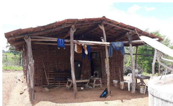
Figura 49: Exemplar de casa de taipa com alpendre frontal em coberta independente e com estrutura em tijolos cerâmicos e coberta como prolongamento da coberta principal com estrutura em madeira.
