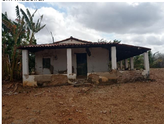
Figura 49: Exemplar de casa de taipa com alpendre frontal em coberta independente e com estrutura em tijolos cerâmicos e coberta como prolongamento da coberta principal com estrutura em madeira.
