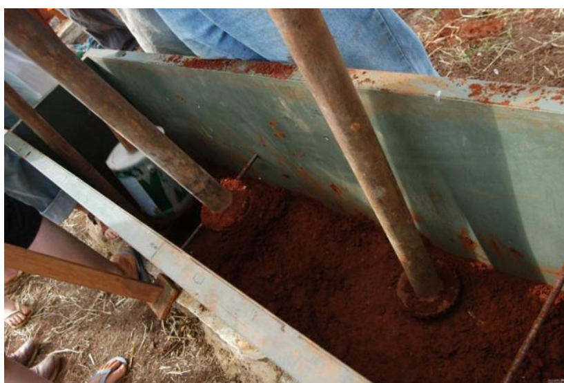
Figura 29: Apiloamento do barro na técnica da taipa de pilão.
