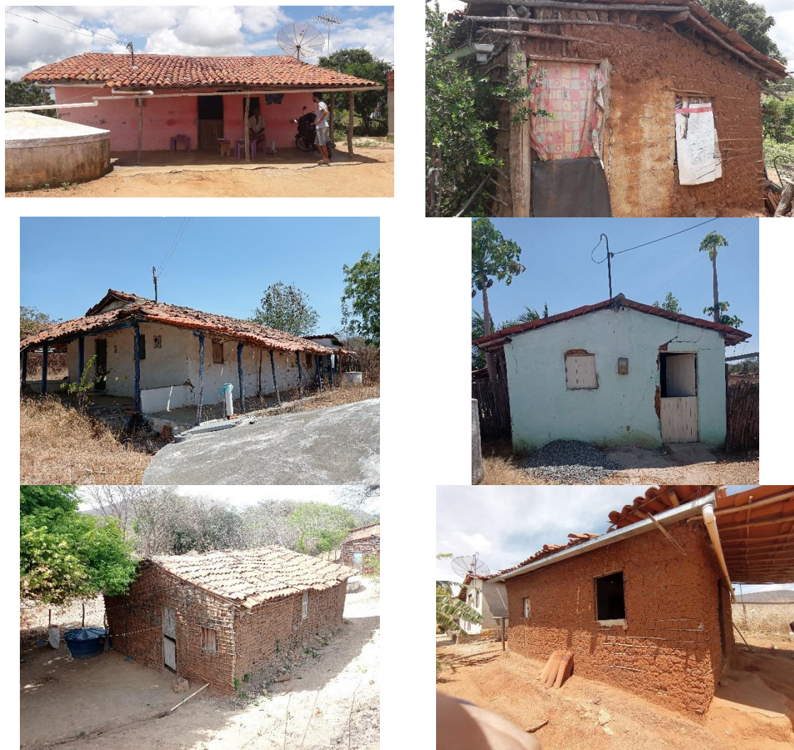
Figura 44: Fotografias de exemplares em taipa de mão revestida e não revestida.
