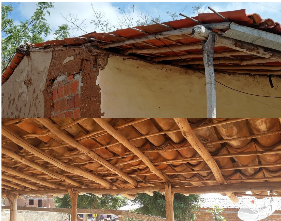
Figura 54: Fotografias de detalhes do madeiramento das coberturas e troncos e galhos utilizados.
