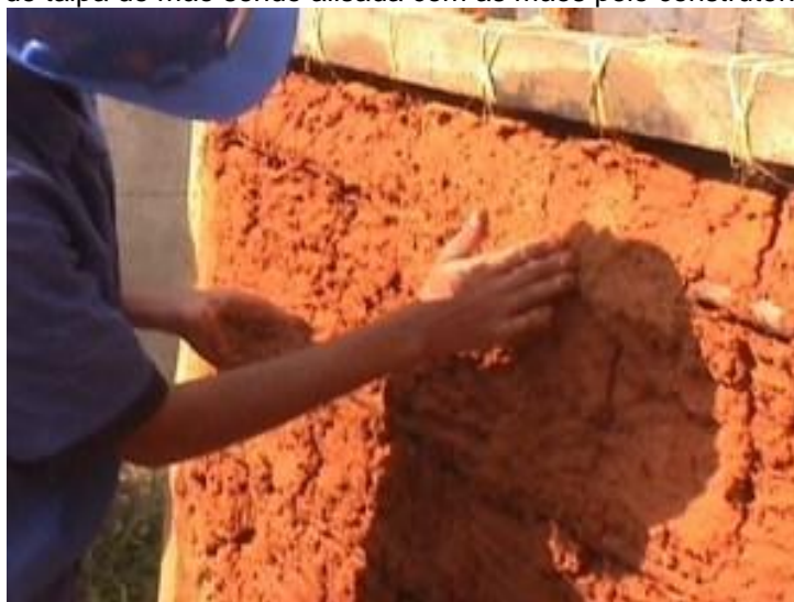
Figura 30: Parede de taipa de mão sendo alisada com as mãos pelo construtor.
