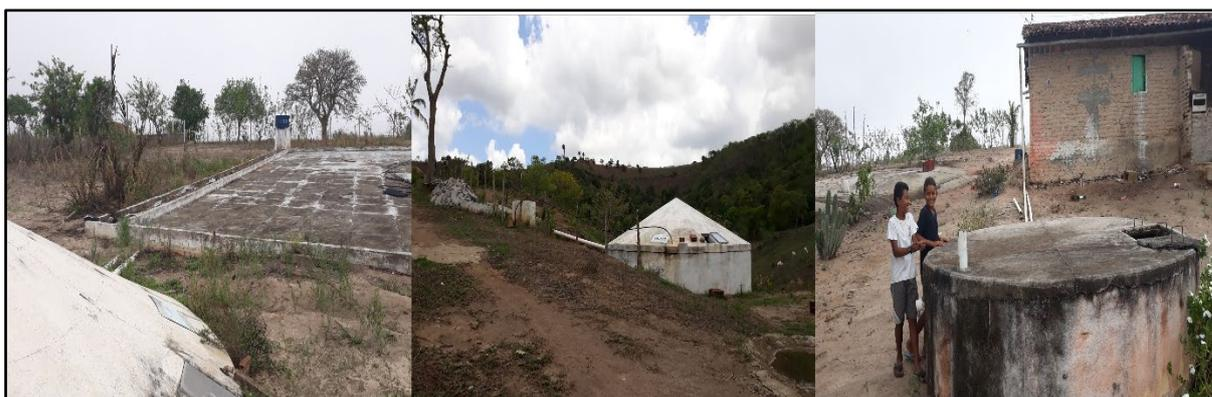
Figura 40 - Fotografia das estratégias utilizadas para a captação e armazenamento da água (cisternas calçada, enxurrada e de placa) nos agroecossistemas da EcoBorborema.
