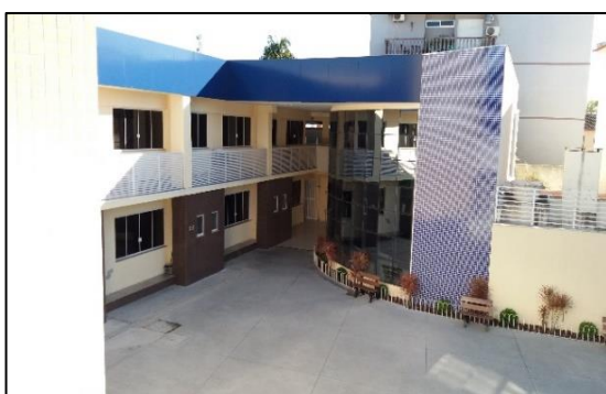
Figura 5: Vista superior do pátio interno Fonte: Autor (2019)
