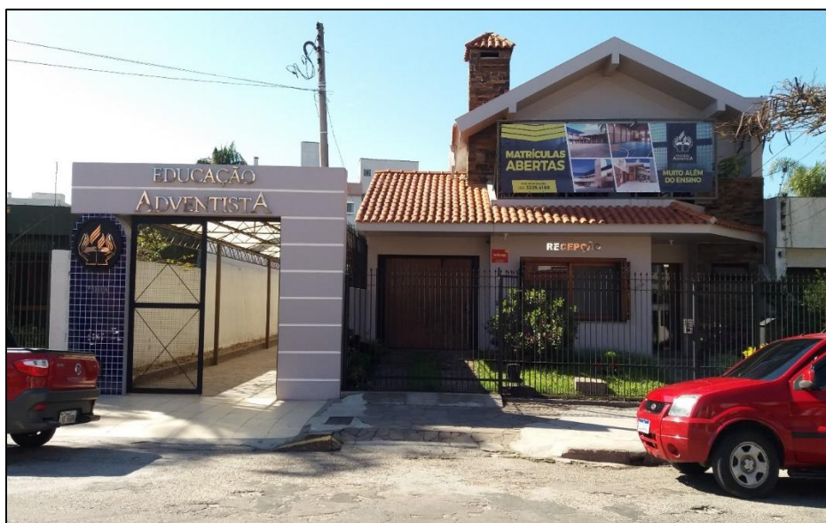
Figura 1: Fachada da Escola Adventista de Pelotas Fonte: Autor (2019)
