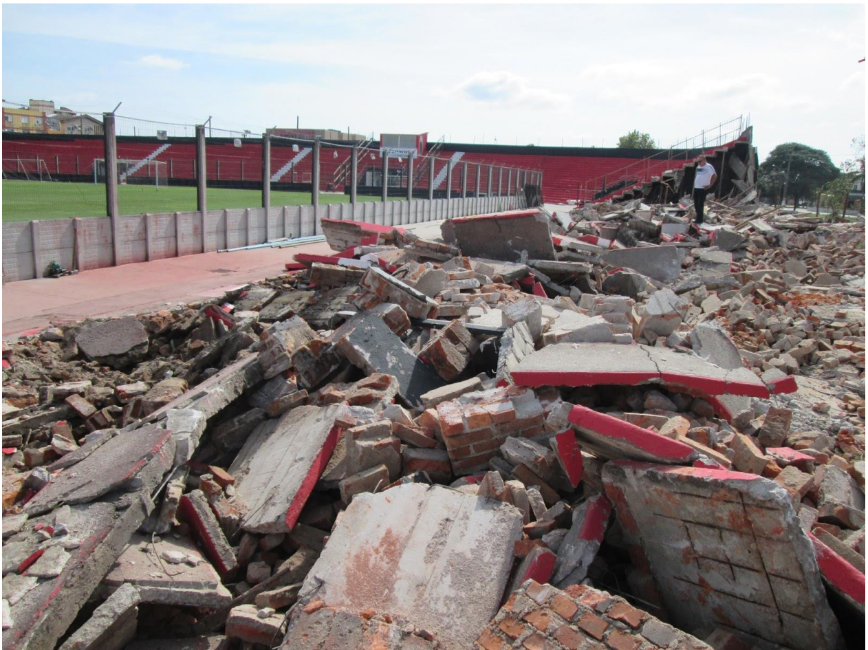
Figura 7 - Demolição da arquibancada sul do estádio Bento Freitas
