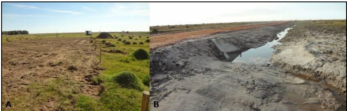
Figura 14 – Etapa de movimentação de terra (A), abertura de acessos (B).
