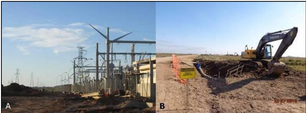
Figura 12 - Subestação coletora (A), Vala aberto para lançamento de cabos (B).
