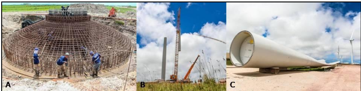
Figura 13 - Etapas da construção de aerogeradores.
