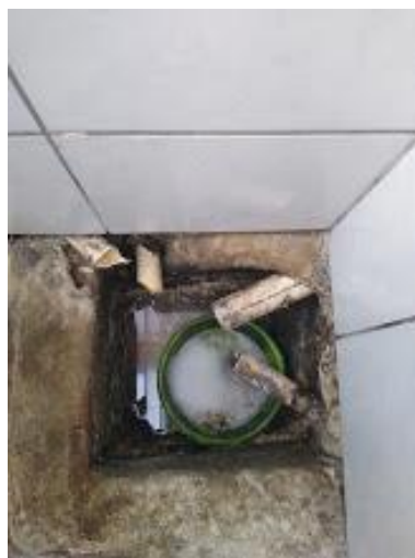
Figura 46- Utilização de sabão em pó para desengordurar as caixas de passagem. Fonte: AUTOR, 2020.
