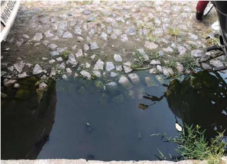
Figura 4.29: Lama, areia e água empoeirada no meio-fio do trecho da Rua Tiradentes, na cidade de Pelotas. Fonte: Autor, 2019.
