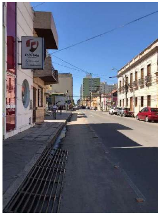
Figura 4.37 - Condições de uso e sinalização da ciclofaixa, no trecho da rua Felix da Cunha, em Pelotas. Fonte: Autor, 2019.
