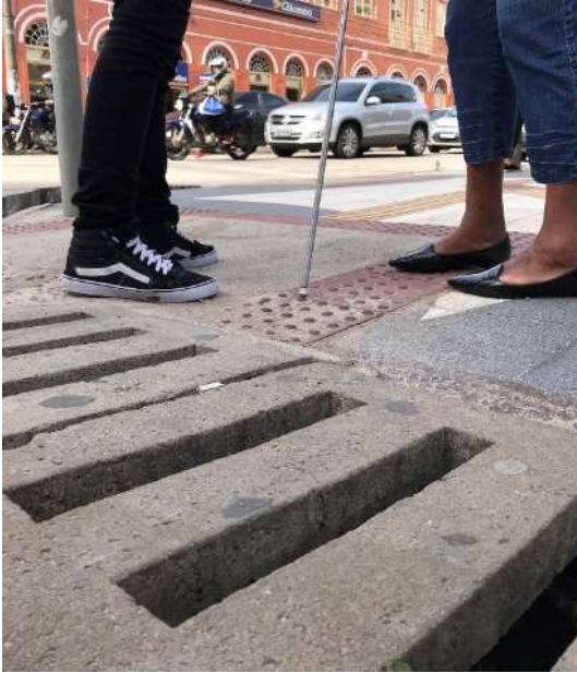
Figura 4.8: Piso tátil direcionado para as grelhas de concreto, na rua General Osório em Pelotas. Fonte: Autor, 2020.
