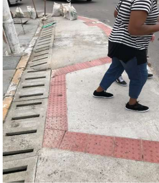
Figura 4.9: Grelhas de concreto na travessia, na rua General Osório em Pelotas. Fonte: Autor, 2020.
