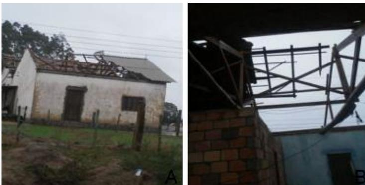
**Figura 34 - Imagens de destelhamentos no interior de Arambaré.**
