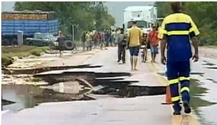
**Figura 26 - Imagem de bloqueio por colapso de rodovia no RS devido às chuvas.**
