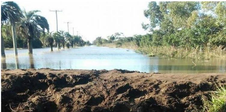
**Figura 30 - Dique para contenção de águas do Arroio Velhaco em Arambaré.**
