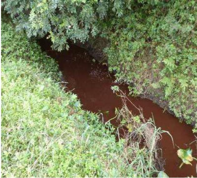
**Figura 51 - Resíduos do tratamento de água no canal de drenagem.**
