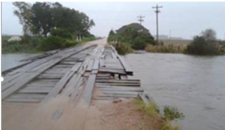
**Figura 18 - Fotografia da Estrada Costa Doce com bueiros de tubos de concreto danificados e recapagem de compactação do solo danificado, além de valos de drenagem pluvial entupidos em uma extensão de 10 quilômetros e ponte danificada.**
