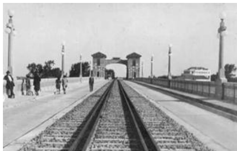
Figura 15. Vista da Ponte Mauá, a partir do lado brasileiro em direção ao uruguaio. 1930.
