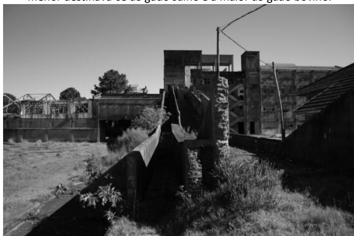
Figura 4 – Fotografia das rampas de subida dos animais à sala do abate. A rampa menor destinava-se ao gado suíno e a maior ao gado bovino.
