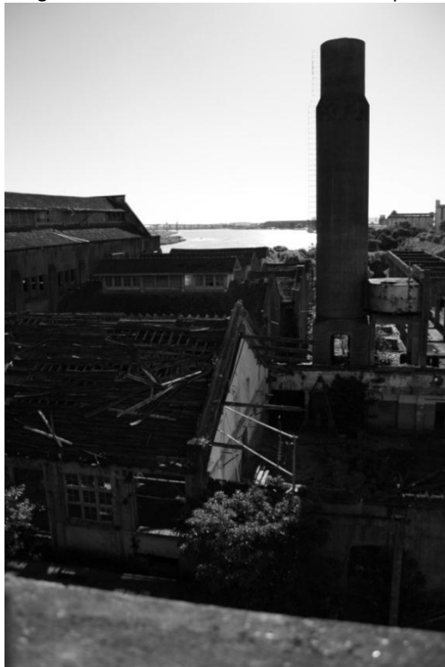
Figura 13 – Fotografia da mesma chaminé vista de outro prédio do entorno.
