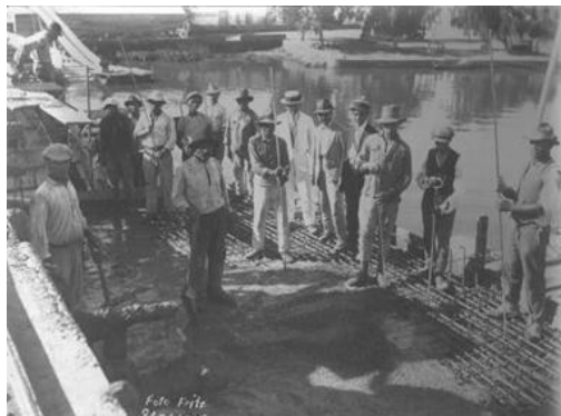
Figura 13. Trabalhadores na construção da Ponte Internacional Barão de Mauá, 1928.
