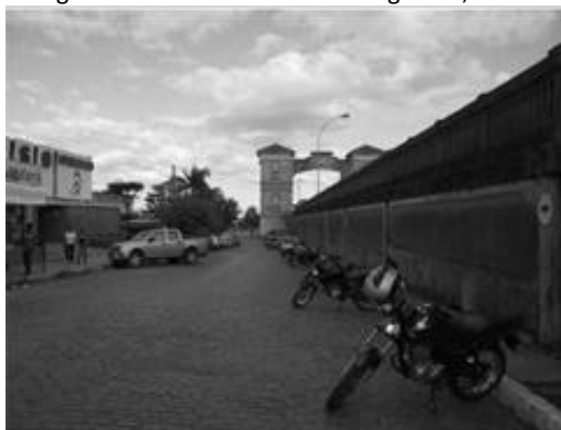
Figura 20. Muro de Concreto. Jaguarão, 2009.
