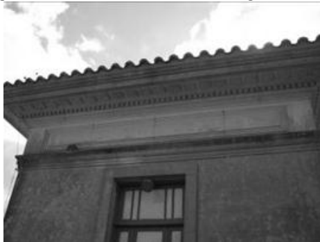
Figura 23. Detalhe: beiral e cimalha. Jaguarão, 2009.
