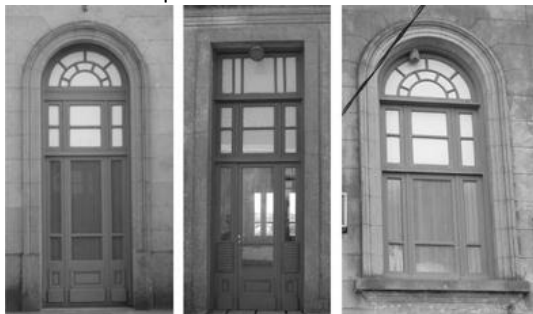
Figura 25. Detalhe das esquadrias de madeira das torres. Rio Branco, 2009
