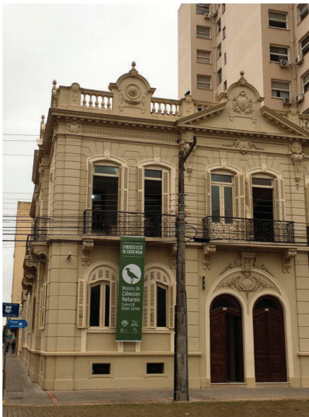
Figura 01 - Fachada do prédio sede do Museu de Ciências Naturais Carlos Ritter, junto à Praça Coronel Pedro Osório, Casarão 1, reinaugurado em 13 de maio de 2019.
