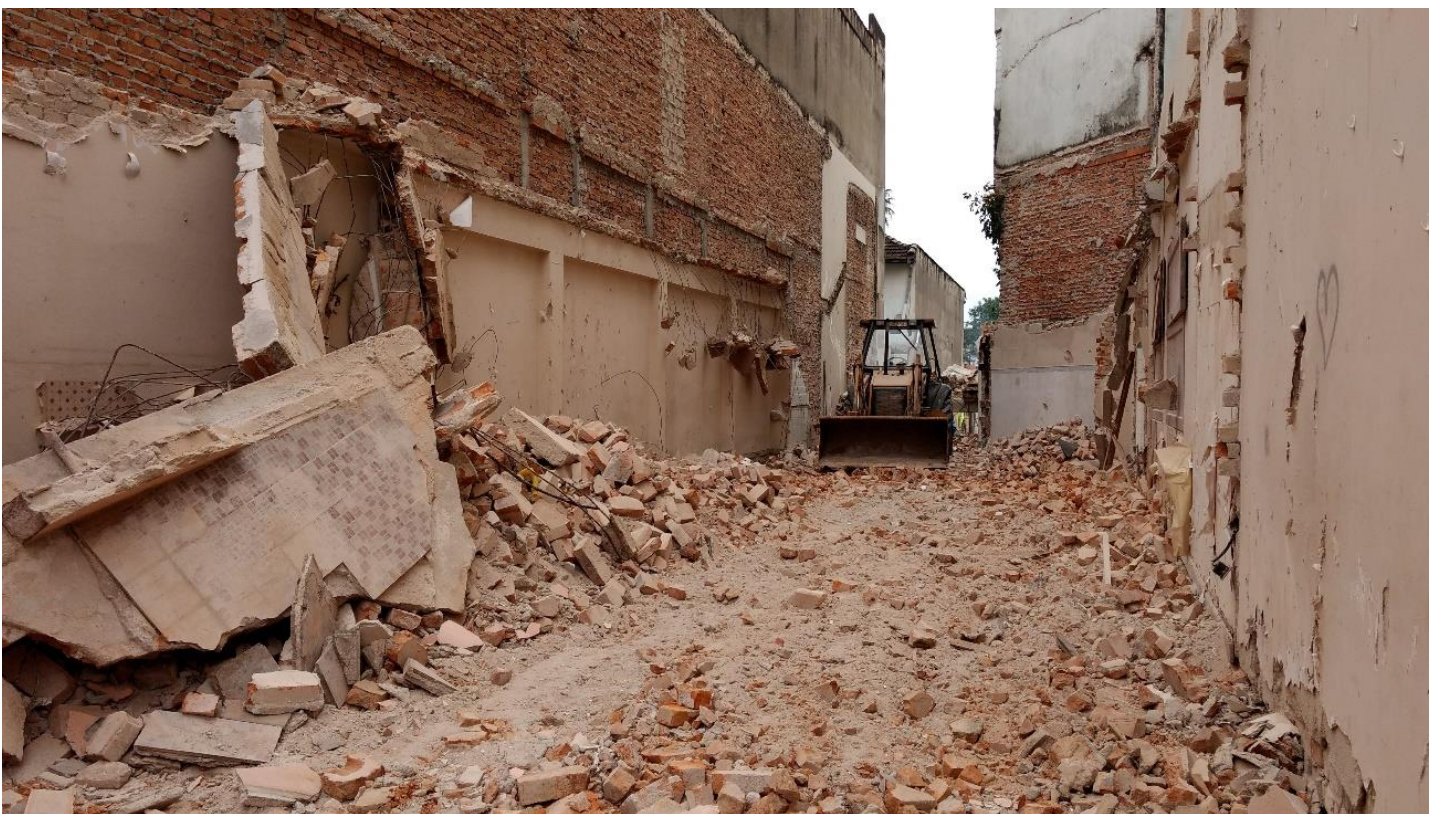
Figura 24 – Fernanda Fedrizzi. Acabou-se , 2019. Registro da demolição da casa. Fonte: Arquivo pessoal.
