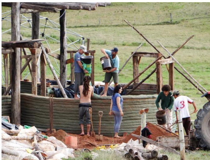
Figura 1- Oficina de construção de parede, técnica de Superadobe. Fonte: Acervo Casa Redonda.
