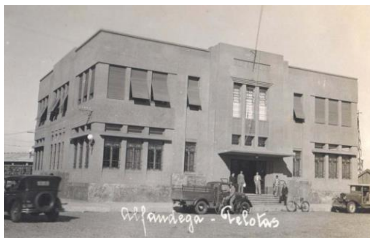
Figura 14 - Fachada prédio Justiça Federal (1938), Pelotas/RS.
