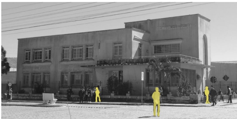
Figura 79 - Fachada principal da escola Marques de Souza, realce da escala dos pedestres em relação ao prédio.
