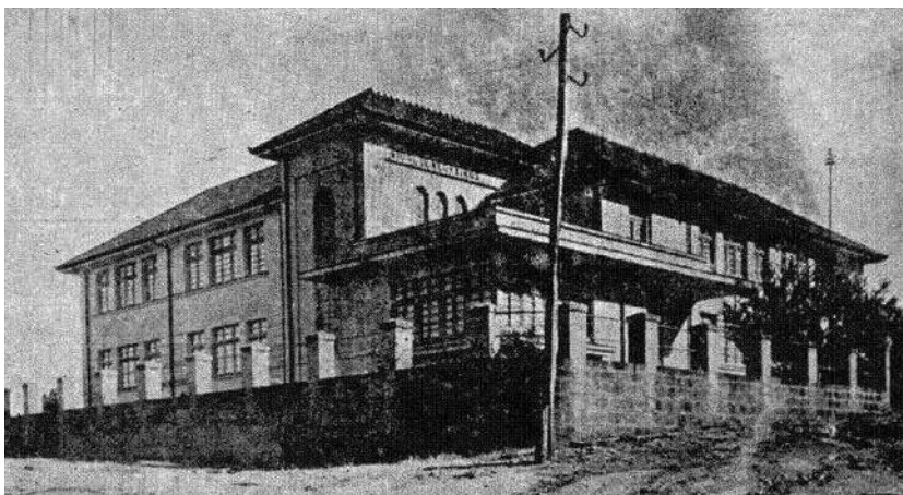
Figura 35 - Escola Estadual de Ensino Fundamental de Estrela. Estrela/RS.
