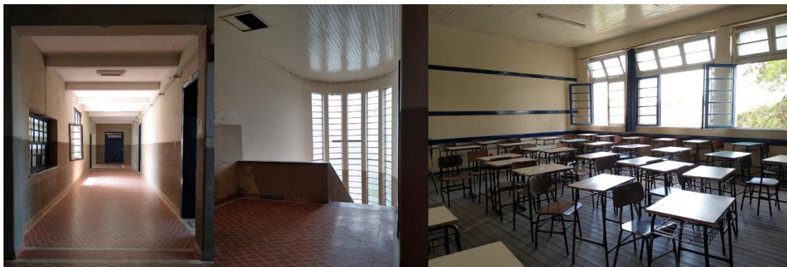
Figura 61 - Imagens internas da escola Assis Brasil, circulação, entrepiso e sala de aula. Fonte: Acervo da autora (2020).
