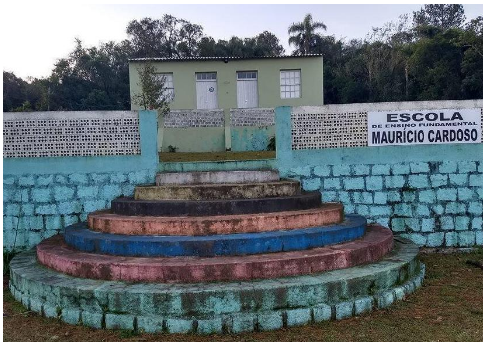
Figura 7 - Fachada da escola Maurício Cardoso Fonte: Arquivo pessoal
