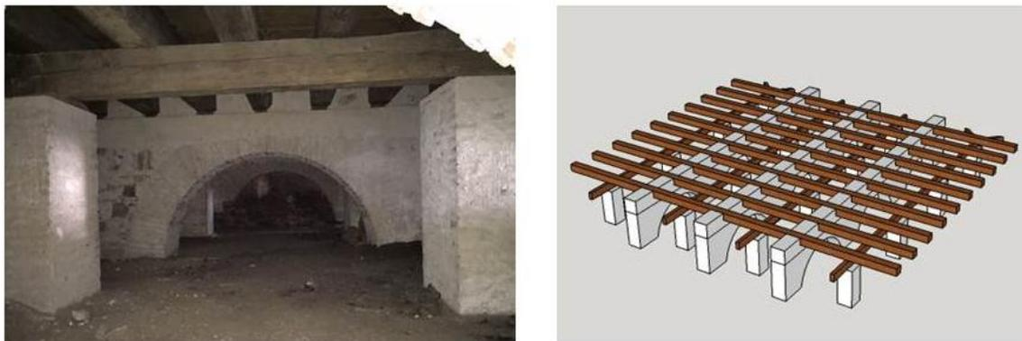
Figura 23: Visão interna do porão/senzala (esquerda). Maquete eletrônica da trama de barrotes (direita).
