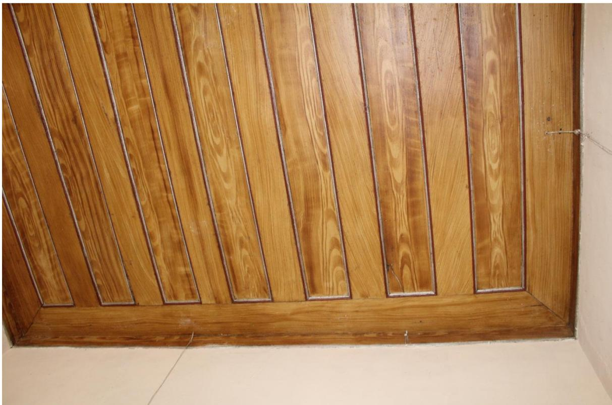
Figura 48: Detalhe do forro de madeira.
