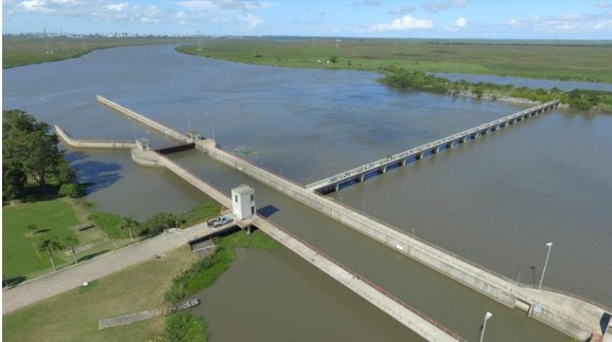
Figura 1 – Comportas e canal de eclusagem da barragem-eclusa do canal São Gonçalo.
