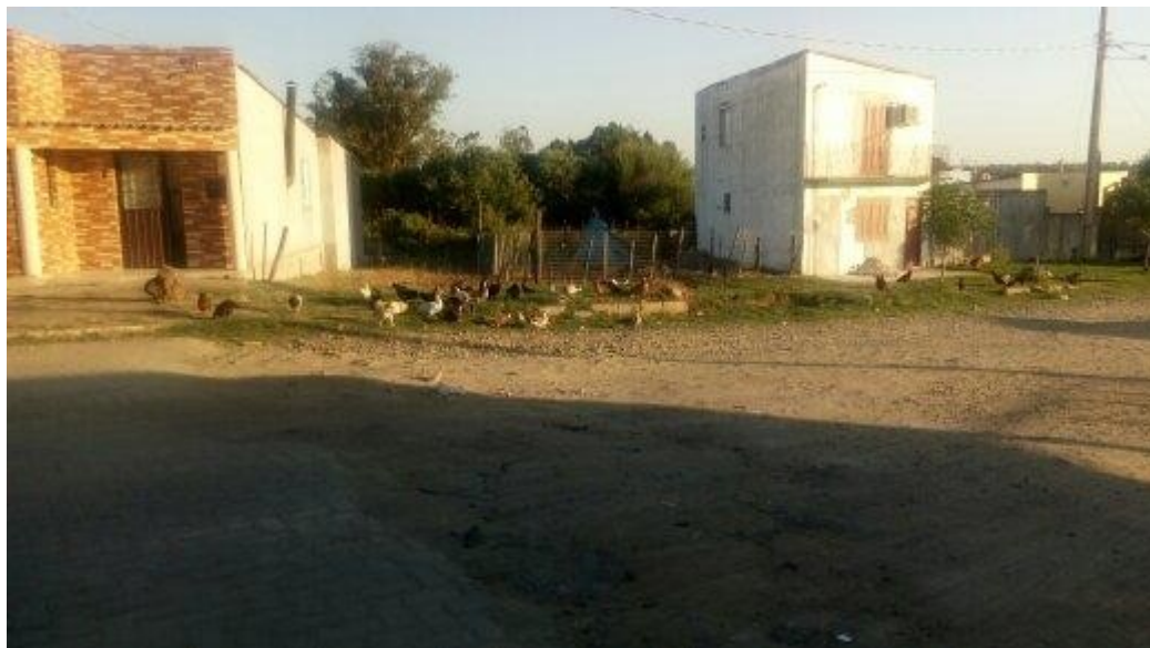
Figura 2: Final do calçamento da rua Odilo Gonçalves
