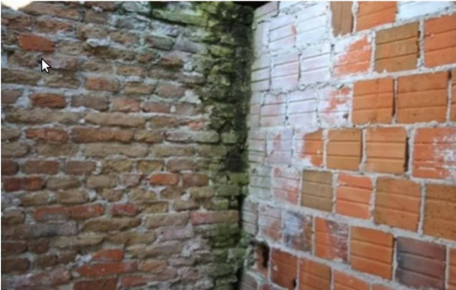
Anexo Q. Foto 05. Detalhe das diferentes técnicas construtivas no interior do edifício. Fonte: Banco de dados do LÂMINA. (2012).
