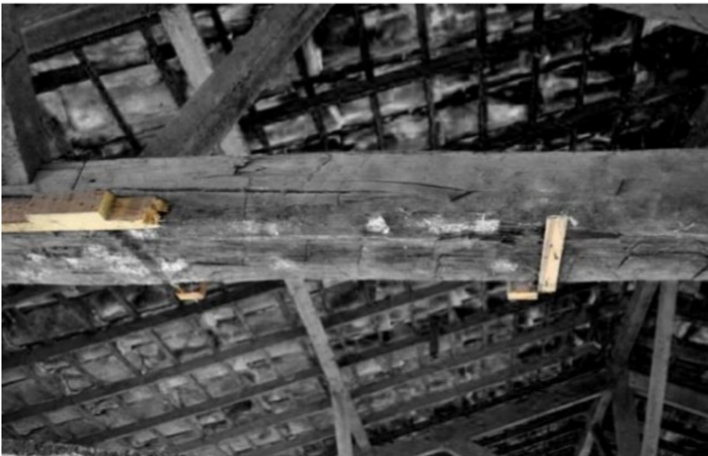
Anexo R. Foto 06. Detalhe de madeiramento recente aplicado ao telhado da edificação. Fonte: Banco de dados do LÂMINA (2012)
