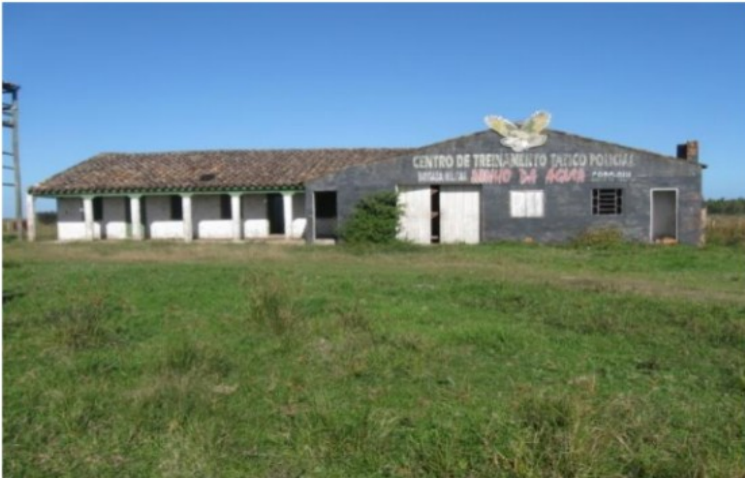
Anexo O. Foto 03. Vista Frontal da edificação na Chácara da Brigada. Fotos de LOURENSO & ROSA (2011).
