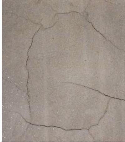
Figura 7 – Revestimento apresentando fissuração em mapa, típica de argamassas com alta retração.
