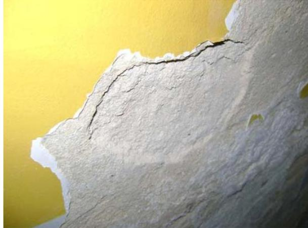
Figura 12 - Incidência de descolamento com pulverulência.
