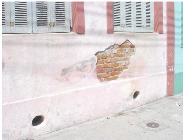
Figura 11 - Descolamento em placas de revestimento argamassado.
