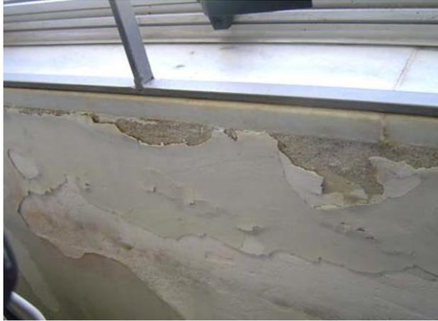
Figura 15 - Deterioração do reboco devido à infiltração de água pela janela.
