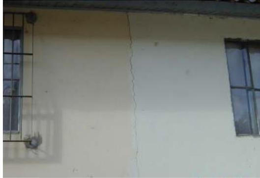
Figura 9 - Fissura linear entre módulos de dois sobrados.
