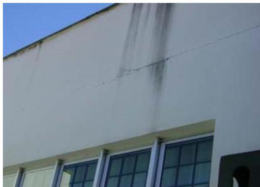
Figura 8 - Fissura horizontal.
