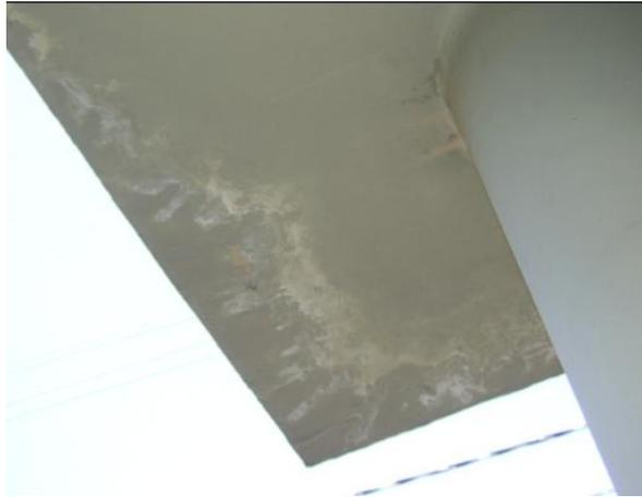
Figura 13 - Eflorescência em laje de cobertura.
