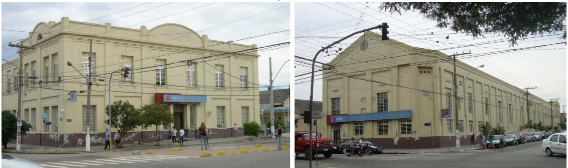
Figura 58: Companhia Estadual de Energia Elétrica. Pelotas. RS. Fonte: Fotos do autor, 2012.
