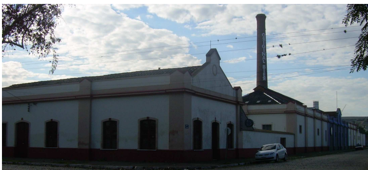
Figura 27: Fiação e Tecidos Pelotense, fachada Rua Alm. Tamandaré. Pelotas. RS. Fonte: Foto do autor, 2010.
