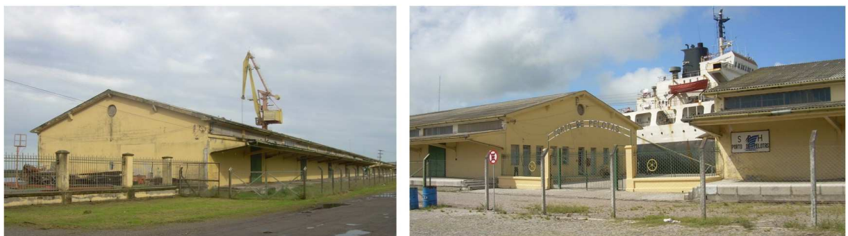
Figura 30: Armazéns da SPH. Pelotas. RS. Fonte: Fotos do autor, 2012.
