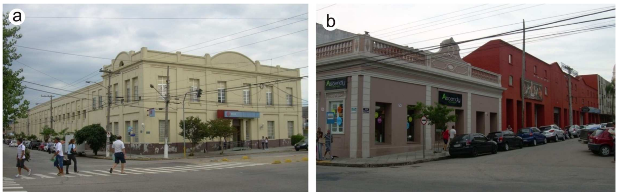
Figura 6: (a) Companhia de Energia Elétrica; (b) Cervejaria Ritter. Pelotas. RS. Fonte: Fotos do autor, 2011.
