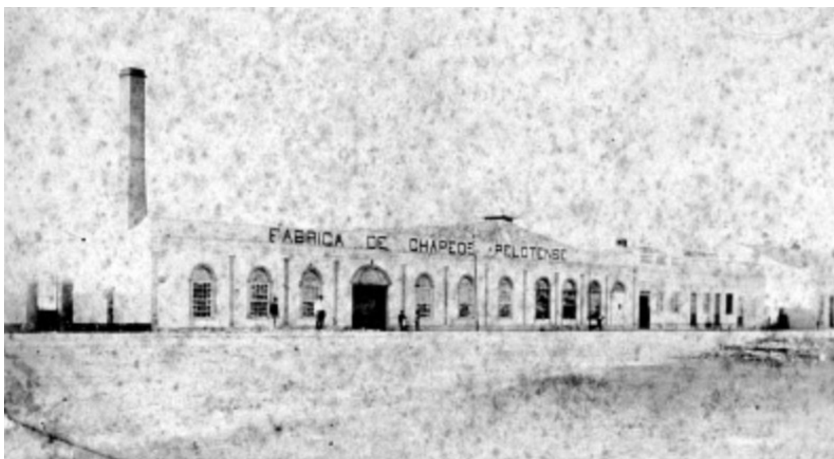
Figura 165: Fachada Principal da Fábrica de Chapéus Pelotense. Pelotas. RS. Fonte: ACERVO DA BIBLIOTECA PÚBLICA PELOTENSE.
