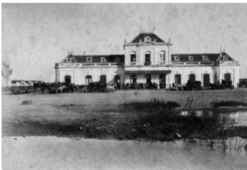
Figura 64: Estação da estrada de ferro, vista do Arroio Santa Bárbara. Pelotas. RS.
