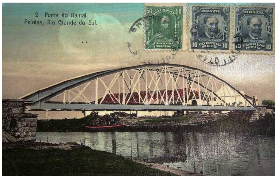
Figura 72: Ponte Metálica sobre o Arroio Santa Bárbara, do Ramal Ferroviário. Pelotas. RS. Fonte: VIVA o charque, s.d.
