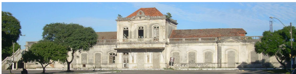
Figura 53: Estação Pelotas da estrada de ferro, localizada na Praça Rio Branco. Pelotas. RS.
