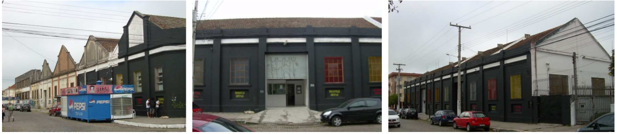
Figura 41: Moinho Santista, esquina Rua Alberto Rosa com Rua Alm. Tamandaré, parte da edificação utilizada pelo Curso de Teatro-UFPEL. Pelotas. RS. Fonte: Fotos do autor, 2012.
