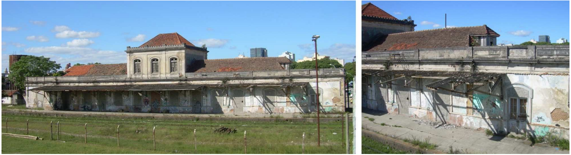
Figura 55: Estação Pelotas da estrada de ferro, fachada posterior. Pelotas. RS. Fonte: Fotos do autor, 2011.
