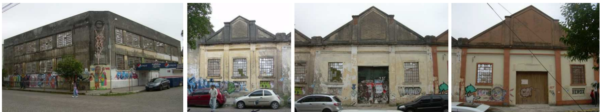
Figura 40: Moinho Santista, restando somente as fachadas, Rua Benjamin Constant e Rua Alberto Rosa. Pelotas. RS. Fonte: Fotos do autor, 2012.
