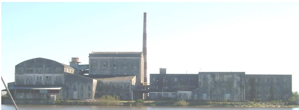
Figura 14: Engenho São Gonçalo, vista do Canal São Gonçalo. Pelotas. RS.
