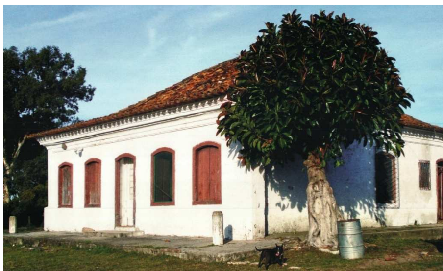
Figura 86: Sede da Charqueada e Fábrica de Línguas São Mathias. Pelotas. RS. Fonte: GUTIERREZ, 2010.
