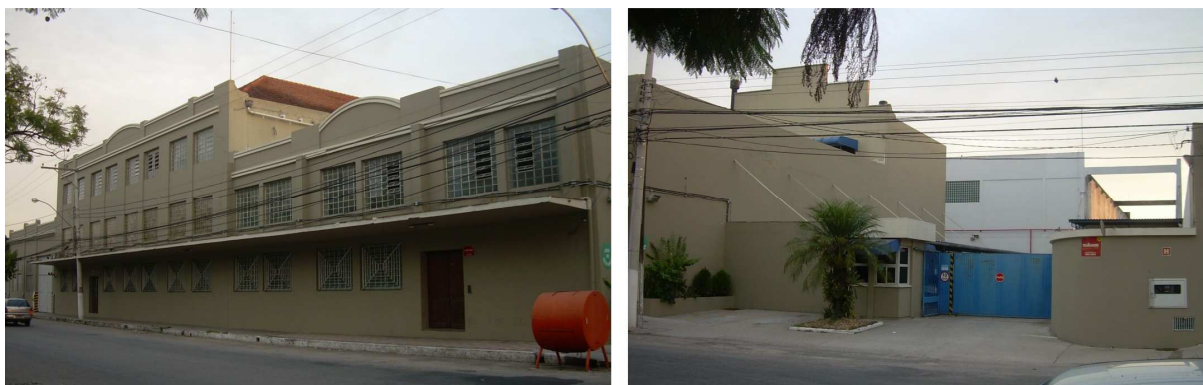
Figura 60: Fábrica Rheingantz. Pelotas. RS. Fonte: Fotos do autor, 2012.
