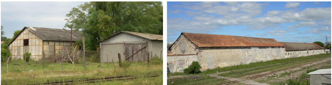
Figura 56: Estação Pelotas da estrada de ferro, armazéns. Pelotas. RS. Fonte: Fotos do autor, 2012.
