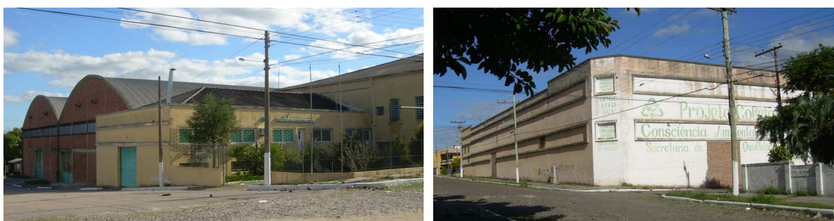
Figura 44: Conjunto de edifícios do IRGA, Rua João Manoel, nº301. Pelotas. RS.
