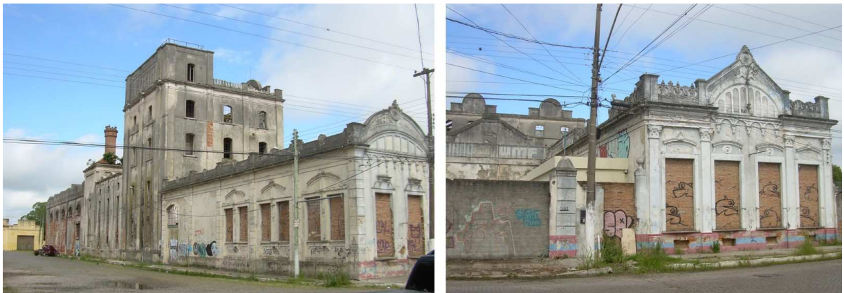
Figura 34: Antiga Cervejaria Sul Rio-Grandense, frontaria da Rua José do Patrocínio e Rua Benjamin Constant. Pelotas. RS. Fonte: Fotos do autor, 2012.
