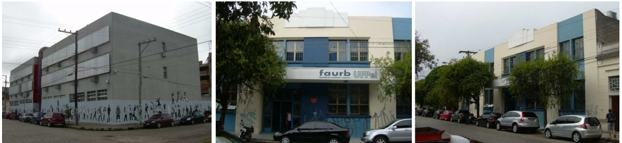
Figura 39: Antiga Cosulã, atual Centro de Artes (CA-UFPEL), Faculdade de Arquitetura e Urbanismo (FAURB-UFPEL). Pelotas. RS. Fonte: Fotos do autor, 2012.
