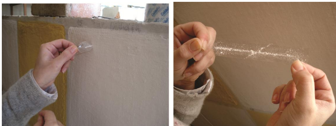
Figura 53 - Retirada da fita adesiva e resíduos.
