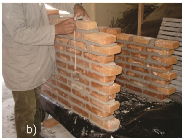
Figura 22 (a e b) - Sequência de fotos da execução do protótipo de alvenaria.
