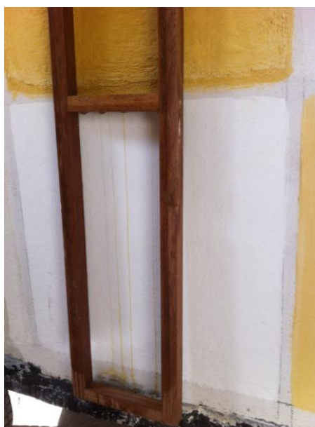
Figura 47 - Detalhe do escorrimento da água e a presença de resíduos de materiais. Fonte: acervo da autora (março de 2012).
