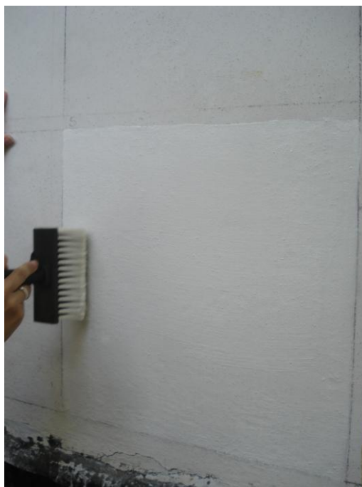
Figura 42- Aplicação de tinta de silicato sem adição de pigmento. Fonte: acervo da autora (fevereiro de 2012).
