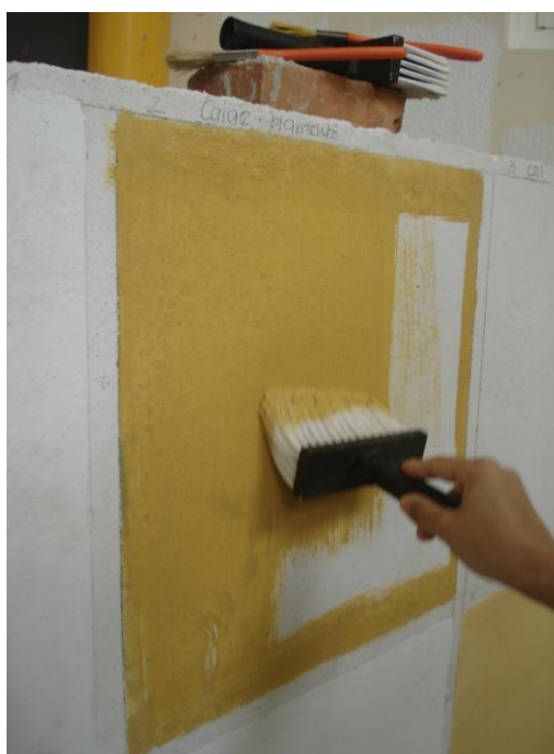
Figura 37 - Aplicação da tinta de cal com pigmento.
