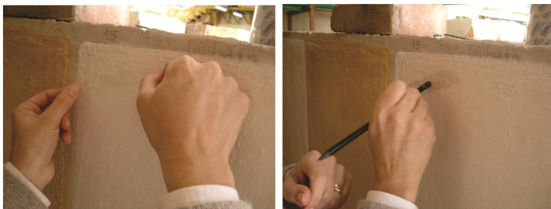
Figura 52 - Aplicação e fixação da fita adesiva.
