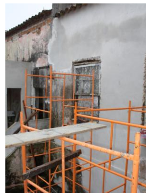
Figura 9 - Detalhe de reboco de cal e areia do Casarão 8. Pelotas-RS. Fonte: acervo da autora(2011).
