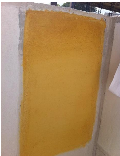
Figura 56 - Quadro revestido com tinta de cal com pigmento localizado na parte superior da alvenaria. Fonte: acervo da autora (dezembro de 2012).
