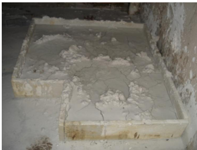
Figura 26 - Preparação da cal hidratada utilizada para o reboco de massa única
