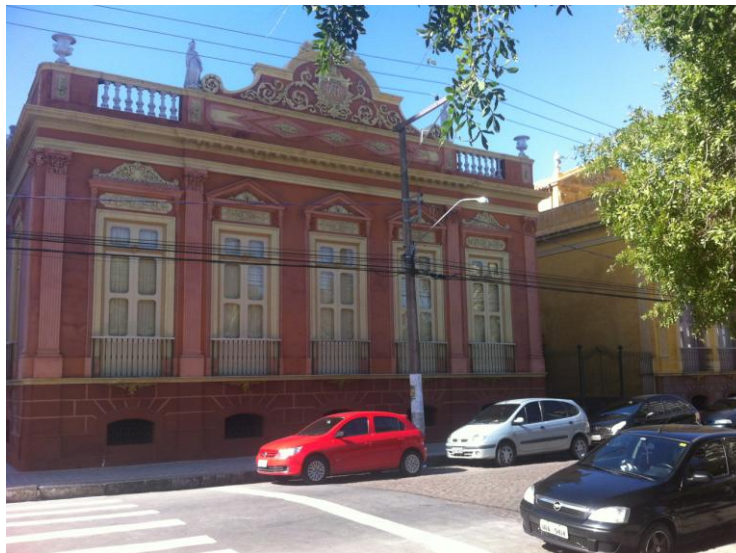
Figura 19 – Fachada do Casarão 8 pintada com tinta de cal Fonte: acervo da autora (agosto de 2013).
