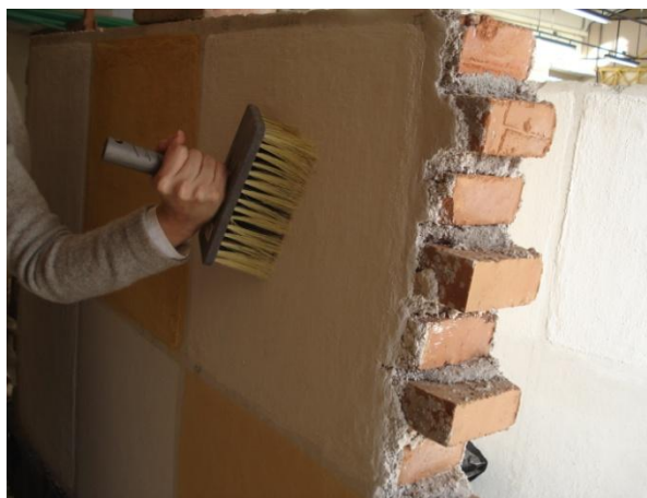
Figura 50- Limpeza da alvenaria.
