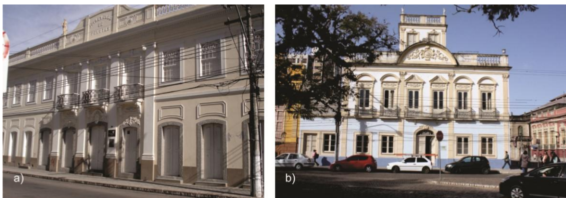
Figura 20 - Prédios históricos com fachadas pintadas com tintas de silicato.
