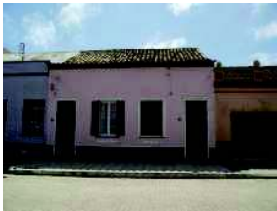
Figura 4.15: Prédios em bom estado de conservação na rua 2 (Fonte: Acervo da autora, 2011)
