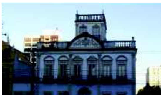
Figura 2.3: Casarão nº2 em Pelotas, RS. Grupamento por similaridade, as seis aberturas verticais se agrupam horizontalmente (Fonte: Acervo da autora, 2010)
