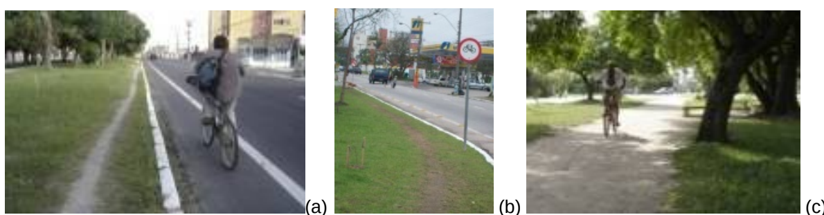
Figura 180. Ciclofaixa da Av. Dom Joaquim. a) ciclista trafegando pela ciclofaixa; b) sinalização vertical da e demarcação com tachões; c) ciclista trafegando pelo canteiro central. Fonte: arquivo pessoal da autora, 2011.
