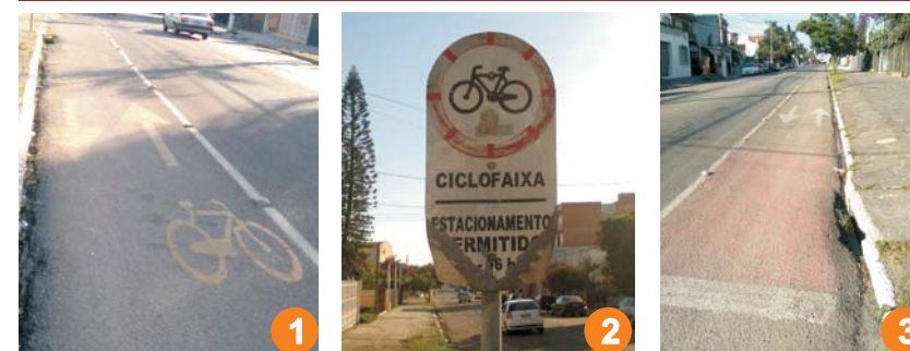
Problemas com sinalização
