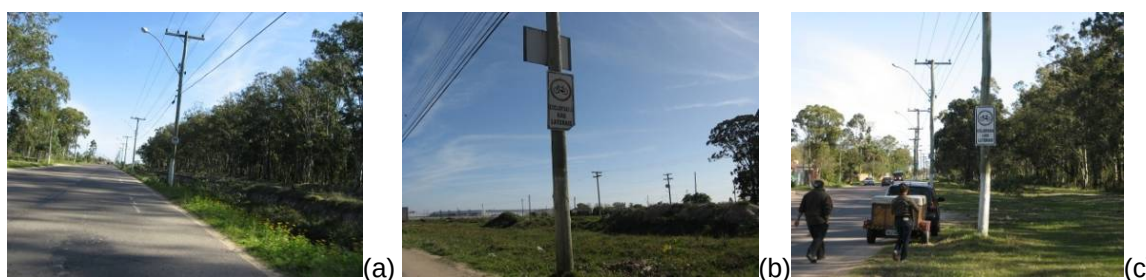
Figura 169. Ciclofaixa da Avenida Ildefonso Simões Lopes. a) vala disposta de forma adjacente a via; (b) presença de placas indicativas da ciclofaixa; (c) ciclofaixa interrompida por veículo estacionado. Fonte: arquivo pessoal da autora, 2011.
