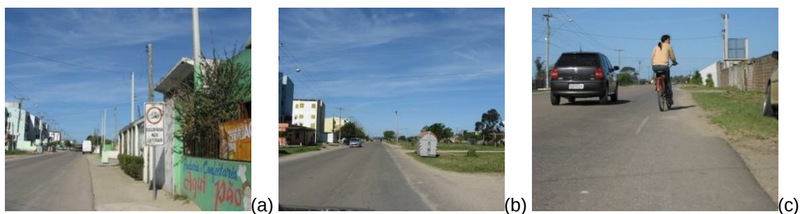
Figura 157. Ciclofaixa da Av. Leopoldo Brod. a) falta de sinalização horizontal indicando o gabarito da ciclofaixa; b) ausência de sinalização horizontal e taxões reflexivos; c) linha tracejada indicando o limite da ciclofaixa. Fonte: arquivo pessoal da autora, 2011.
