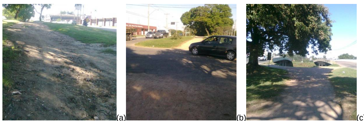
Figura 121. Problemas apontados pelos ciclistas na ciclovia da Av. Bento Gonçalves; a) pavimentação com problemas, b) Cruzamento sem sinalização, provocando desrespeito por parte dos motoristas e c) falta de sinalização que auxilie os ciclistas na travessia da ponte sobre o Canal Santa Barbara Fonte: arquivos pessoais da autora, 2011.
