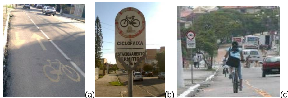
Figura 135. Ciclofaixa Avenida Domingos José de Almeida. a) sinalização direcional de fluxo; b) sinalização vertical; c) ciclista trafegando na ciclofaixa. Fonte: arquivo pessoal da autora, 2011.
