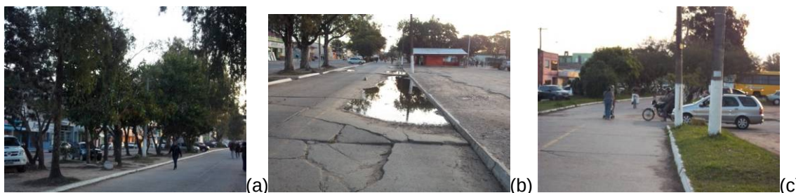
Figura 96. Ciclovia da Avenida Duque de Caxias, trecho 2. a) A vegetação forma uma barreira que impede a iluminação noturna satisfatória, b) Problemas com drenagem e pavimentação, interrompem o trânsito na pista; c) Sinalização deficiente nos Cruzamentos. Fonte: arquivo pessoal da autora, 2011.
