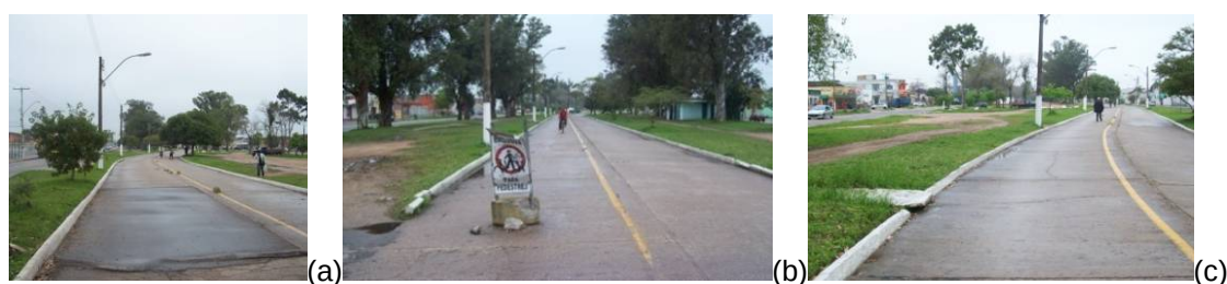
Figura 92. Ciclovía Avenida Duque de Caxias, trecho 1. a) pavimentação com recapeamento com asfalto, b) sinalização vertical e c) drenagem pluvial. Fonte: arquivo pessoal da autora, 2011.
