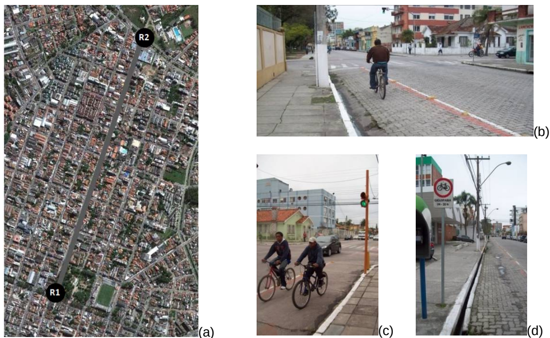
Figura 190. Ciclofaixa da Rua Andrade Neves. a) localização da ciclofaixa entre a Avenida Bento Gonçalves (R1) e Avenida Dom Joaquim (R2), b) trecho da ciclofaixa com pavimentação de blocos de concreto; c) semáforo destinado aos ciclistas que trafegam no sentido oposto ao fluxo; d) sinalização vertical, identificando o horário de funcionamento da ciclofaixa. Fonte: arquivo pessoal da autora, 2011.
