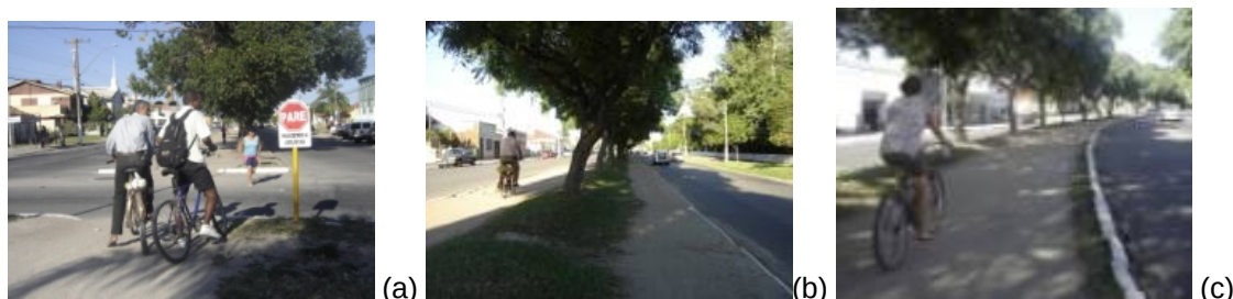
Figura 124. Ciclovia da Avenida Domingos José de Almeida. a) ciclistas em um cruzamento da ciclovia; b) ausência de pavimentação e sinalização adequadas; c) ausência de drenagem e iluminação apropriada. Fonte: arquivo pessoal da autora, 2011.
