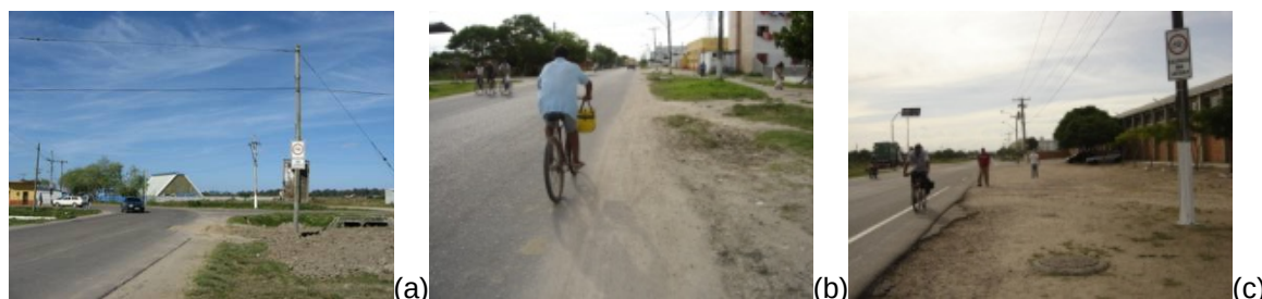
Figura 158. Ciclofaixa da Av. Leopoldo Brod. a) deficiência na sinalização, pavimentação e iluminação no cruzamento; b) ausência de mecanismos de drenagem; c) Erosão lateral do pavimento.
