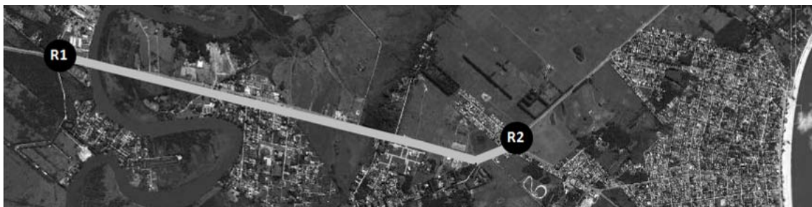
Figura 200. Ciclofaixa da Avenida Adolfo Fetter, compreendida entre a Rótula Bertoldi (R1) e a Avenida Rio Grande do Sul (R2). Fonte: Estudo da autora sobre imagem de satélite, 2011.
