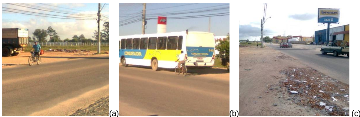
Figura 170. Ciclofaixa da Avenida Ildefonso Simões Lopes. a) falta de demarcação específica da ciclofaixa, b) conflito entre transporte coletivo e os ciclistas c) falta de pavimentação em alguns trechos. Fonte: arquivo pessoal da autora, 2011.
