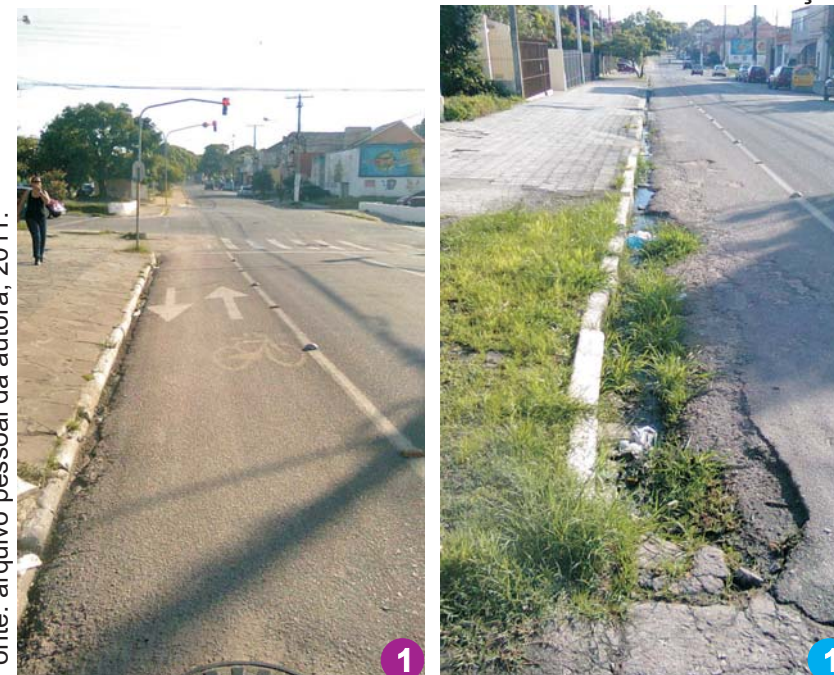
Problemas com pavimentação e drenagem
