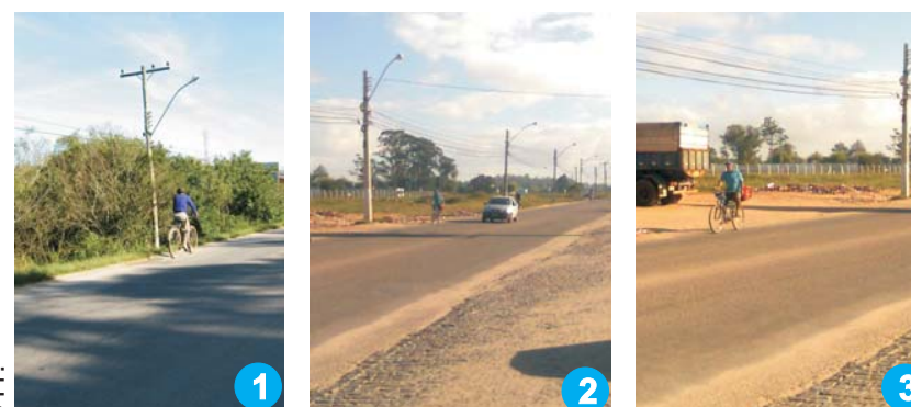
Problemas com drenagem
