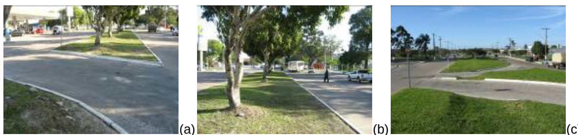
Figura 76. Prolongamento da Avenida Bento Gonçalves. Fonte: arquivo pessoal da autora, 2011.
