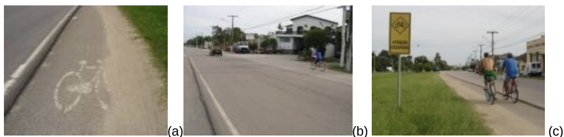
Figura 146. Ciclofaixa da Av. Fernando Osório. a) sinalização horizontal precária; b) ciclistas circulando em loca impróprio; c) sinalização vertical. Fonte: arquivo pessoal da autora, 2011.
