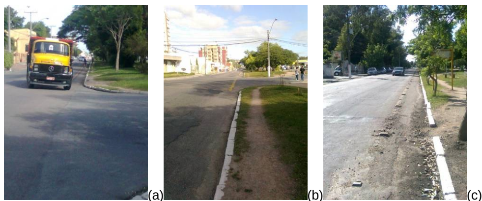
Figura 188. Ciclofaixa da Avenida Dom Joaquim. a) Tráfego de veículos pesados, que muitas vezes aproveitam de sua condição desrespeitando os ciclistas; b) falta de sinalização destinada aos ciclistas não cruzamentos; c) pavimento com problemas Fonte: arquivo pessoal da autora, 2012.
