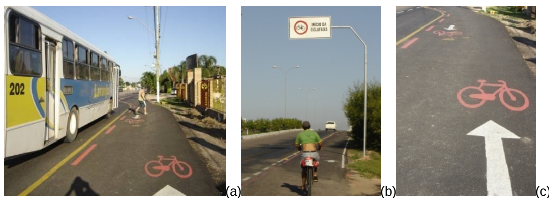
Figura 201. Ciclofaixa da Avenida Adolfo Fetter. a) Solução encontrada para compatibilizar a parada de ônibus e a ciclofaixa; b) sinalização vertical da ciclofaixa; c) sinalização horizontal indicando o sentido de fluxo. Fonte: arquivo pessoal da autora, 2011.
