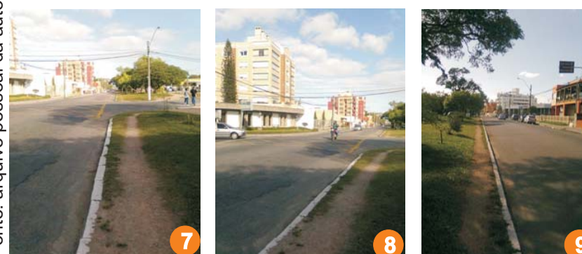
Problemas com sinalização
