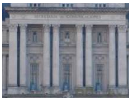
Figura 74 - Palácio dos Correios. Colunas de ordem colossal. Buenos Aires, 1888. Fonte: http://www.panoramio.com/photo/10353505 >. Acesso: 12 ago. 2011.
