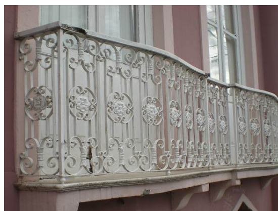
Figura 305 - Gradil de ferro. Residência Antônio da Costa Leite, Pelotas. 1898. Fonte: Foto da autora, 2012.
