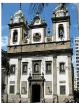
Figura 165 - Fachada. Igreja de São José, 1808-1842.
