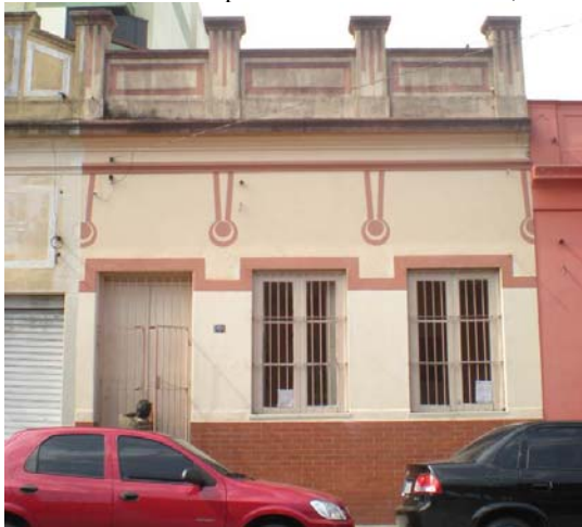
Figura 331 - Fachada atual pela Rua Padre Anchieta, Pelotas. 1899.
