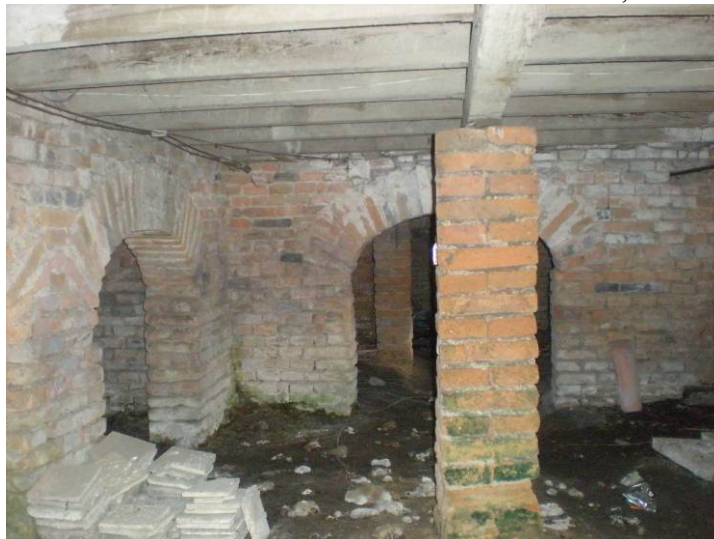
Figura 301 - Porão elevado. Residência Antônio da Costa Leite, Pelotas. 1898.
