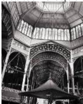
Figura 77 - Mercado San Telmo. Estruturas em ferro aparentes no interior. Buenos Aires, 1897.
