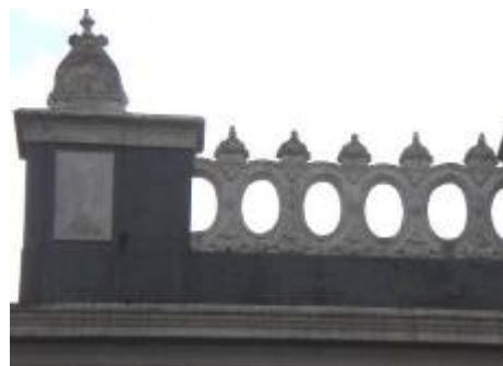
Figura 318 - Platibanda de residência na Rua Dom Pedro II, Pelotas, 2012 Fonte: Foto da autora, 2012.
