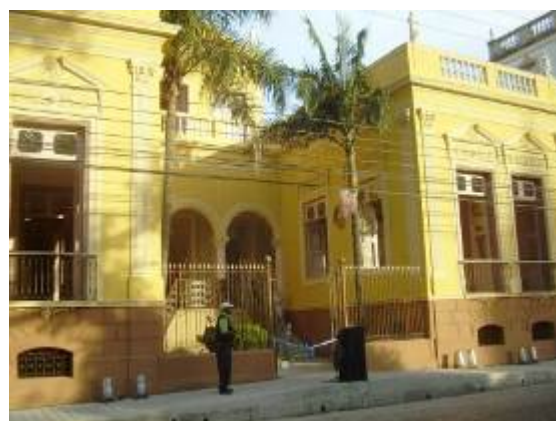
Figura 231 - Fachada da residência do Barão de São Luís, s/d. Fonte: Pelotas Cultural. Disponível em: < pelotascultural.blogspot.com >. Acesso: 10 jul. 2012.
