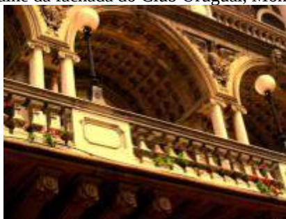
Figura 107 – Detalhe da fachada do Club Uruguai, Montevideu, 1886-88.
