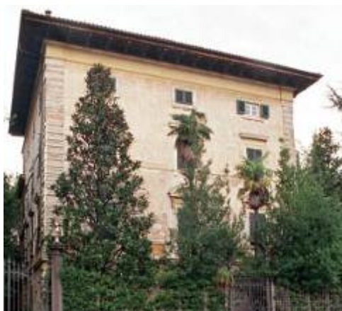
Figura 50 - Fachada da Villa Martinelli , final século XIX, s/d.
