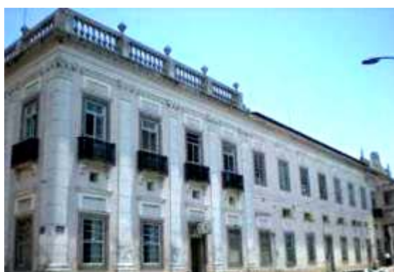
Figura 262 - Fachada da esquina da General Neto da Santa Casa de Misericórdia, Pelotas. 1884 e 1887.
