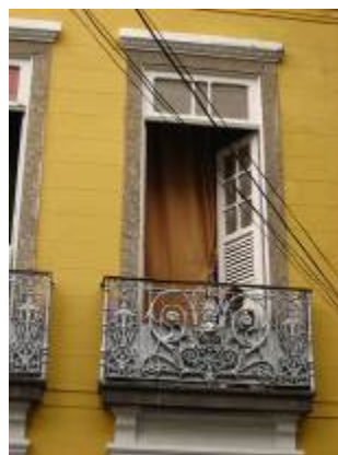
Figura 265 - Detalhe da fachada da rua das laranjeiras. Rio de Janeiro, s/d. Fonte: Preserva SP – Rio de Janeiro, rua das laranjeiras. Disponível em: < http://www.preservasp.org.br/forum/index.php?to pic=70.0 >. Acesso em 13 nov. 2011.
