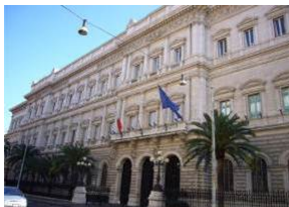
Figura 32 - Banco da Itália. Roma, 1893. Fonte: Disponível em: < http://upload.wikimedia.org/wikipedia/commons/9/9e/Monti_via_Nazionale_Palazzo_Koch_1000117.JPG >. Acesso: 2 jun. 2011.
