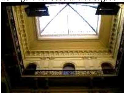
Figura 70 - Casa do Governo Argentino. Cobertura do saguão interno. Buenos Aires, 1883.
