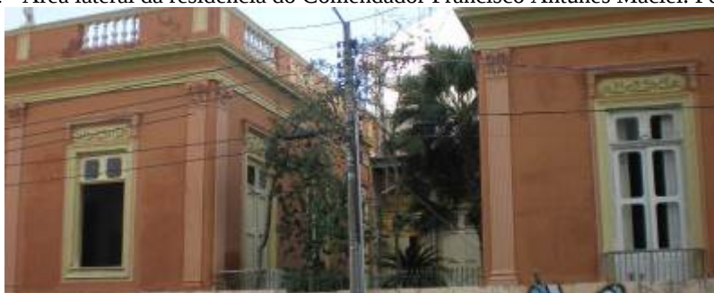
Figura 322 - Área lateral da residência do Comendador Francisco Antunes Maciel. Pelotas. 2012.
