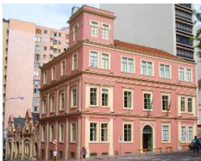
Figura 218 - Fachada da antiga Secretaria de Obras de Porto Alegre, atual Palácio do Ministério Público, Porto Alegre, s/d.
