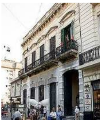
Figura 64 - Fachada da residência da família Ezeiza. Buenos Aires, 1880.
