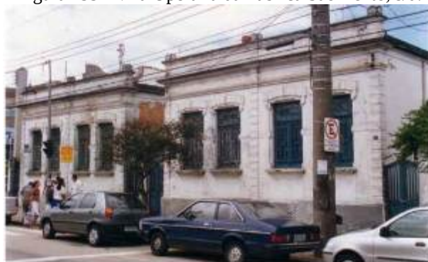
Figura 1 - Vila operária da Fábrica São Bento, em Jundiaí (SP). Fotografia de Philip Gunn, 2002.
