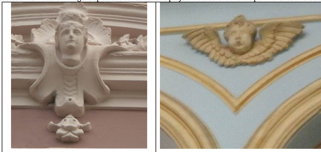
Figura 350 - Ornatos de imagens aplicadas às residências projetadas e/ou executadas por Marcucci. Pelotas, s/d.
