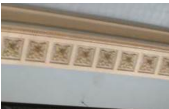
Figura 270 - Detalhe dos lacunários. Capela da Santa Casa de Misericórdia, Pelotas, 2012. Fonte: Foto da autora, 2012.
