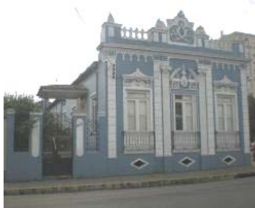
Figura 297 - Residência situada à Rua Dom Pedro II, Pelotas, 2012.
