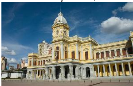
Figura 200 - Fachada da estação central, Belo Horizonte, 1894.
