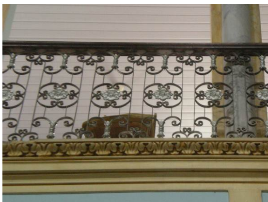
Figura 304 - Gradil de ferro. Capela Santa Casa de Misericórdia, Pelotas. 1884. Fonte: Foto da autora, 2012.
