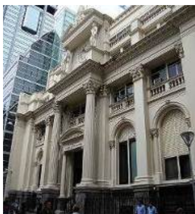
Figura 62 - Fachada do Banco Hipotecário da Província, 1872.
