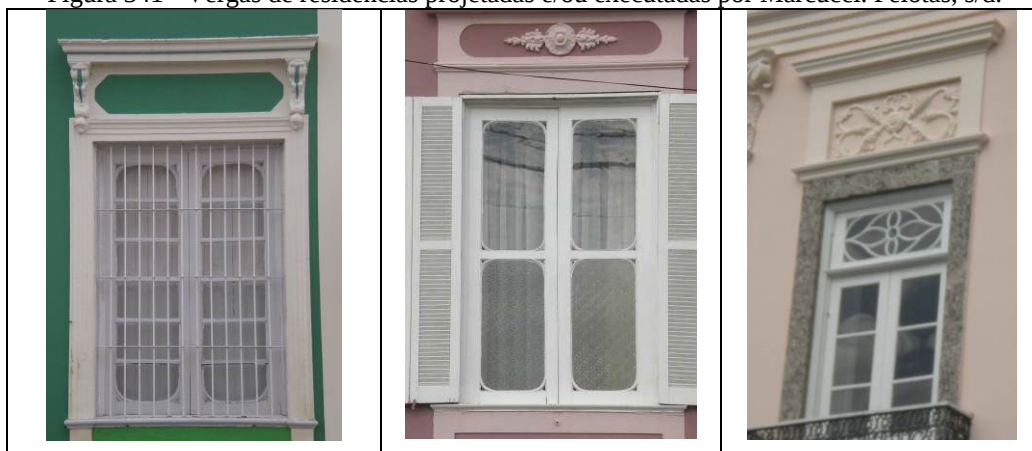
Figura 341 - Vergas de residências projetadas e/ou executadas por Marcucci. Pelotas, s/d.
