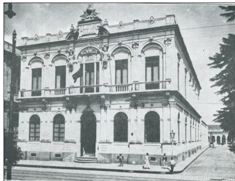
Figura 53: Biblioteca Pública, fotografia antiga da fachada principal, Pelotas, s/d. Fonte: CARRICONDE, 1922, s/p.
