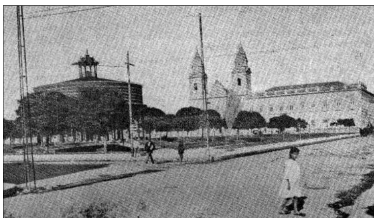
Figura 44: Atual Praça Piratinino de Almeida, com o reservatório de ferro fundido vindo da Escócia e vista do primeiro bloco da Santa Casa e de sua capela ao fundo. Pelotas. s/d. Fonte: GUTIERREZ, 2004, p.253.
