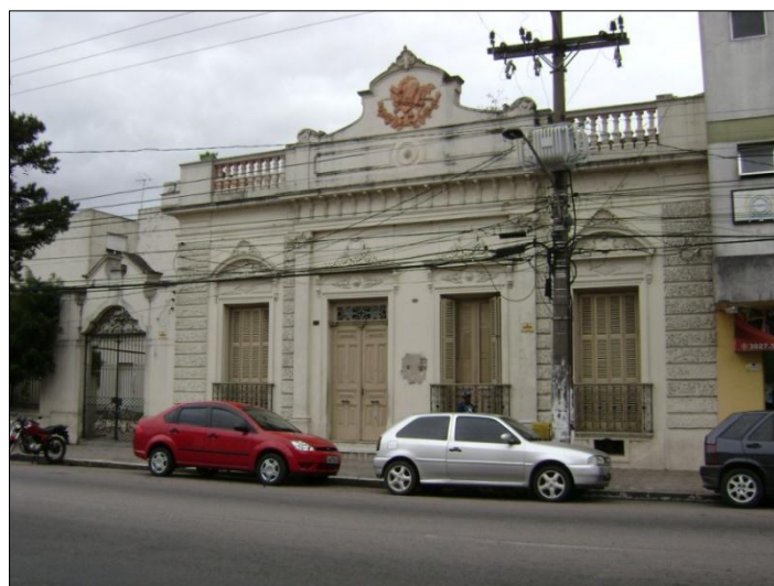
Figura 118: Residência de Carlota Behrendorf, fachada principal, Pelotas, 2010. Fonte: Foto do autor.
