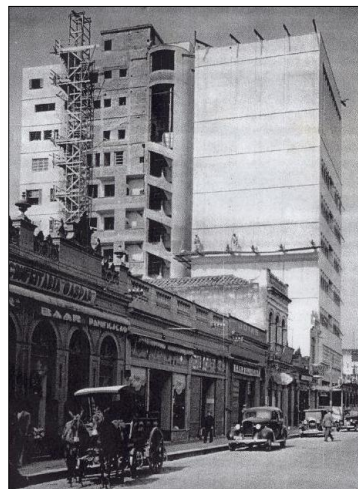
Figura 57: Edifício da Associação Comercial de Pelotas em construção no final da década de 30 do século XX. Fonte: MAGALHÃES, 1999, v.5, p.11.
