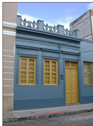
Figura 109: Residência que foi propriedade de Eduardo Gastal, Pelotas, 2010. Fonte Foto do autor.
