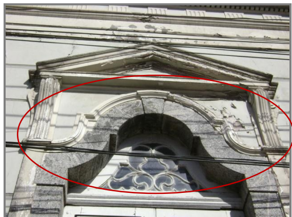
Figura 192: Capela da Sociedade Portuguesa de Beneficência, detalhe da verga e do frontão sobre as aberturas laterais, Pelotas, 2010. Fonte: Foto do autor.
