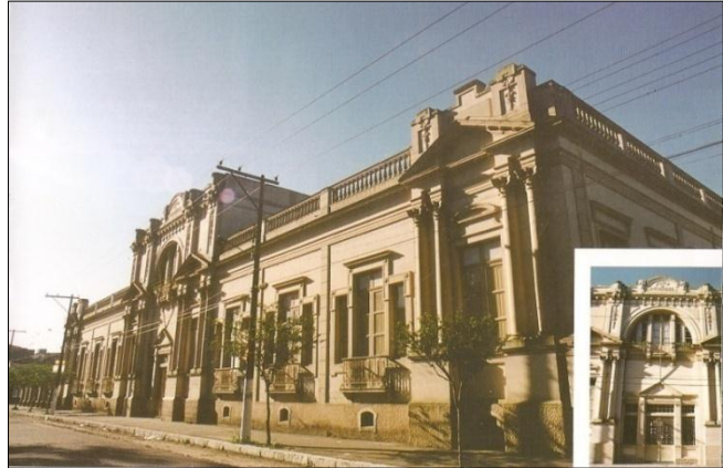
Figura 162: Vista em perspectiva da fachada principal do asilo. Pelotas, s/d. Fonte: MOURA E SCHLEE, 2002, p.89.
