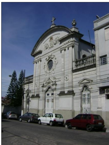
Figura 145 a: Capela da Sociedade Portuguesa de Beneficência, fachada principal, Pelotas, 2010. Fonte: Foto do autor.
