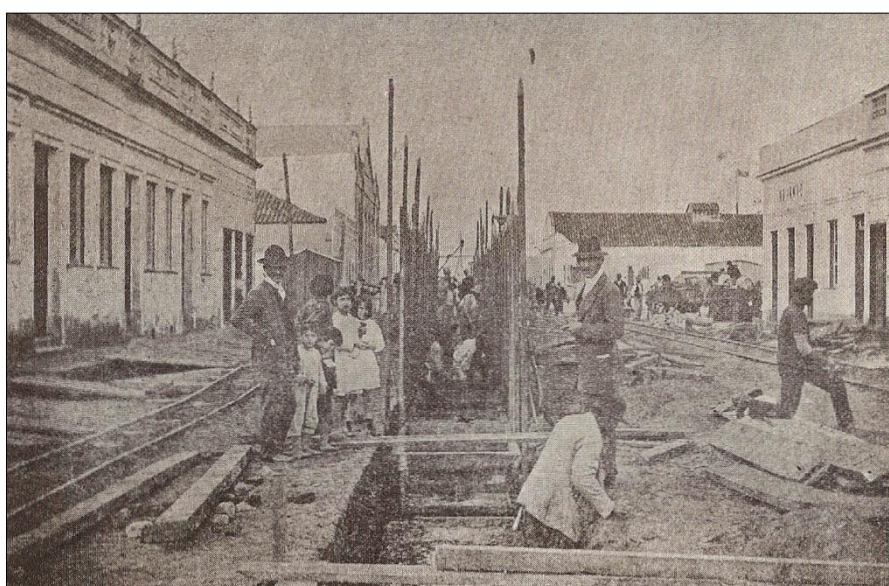
Figura 47: Execução das obras de recolhimento de esgoto, Pelotas, s/d. Fonte: MAGALHÃES, 1990, v.5, p.18.
