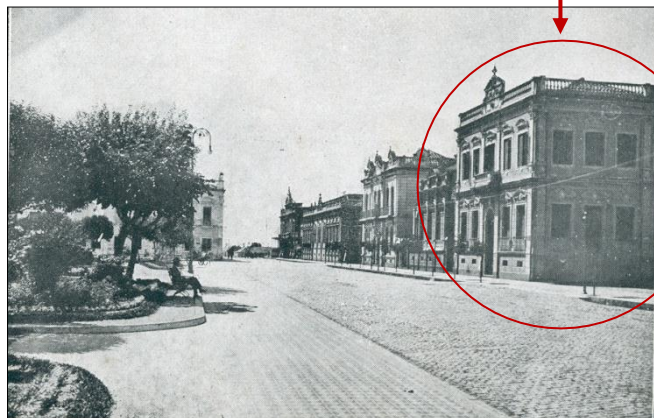
Figura 163: Esquina da residência de Pedro Luis Osório e Noêmia Assumpção Osório à direita. Pelotas, s/d. Fonte: CARRICONDE, C., 1922, s/p..
