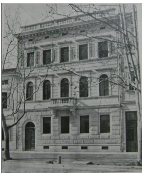
Figura 35: Facciata, do arquiteto Gerolamo Luzzato, s/d. Fonte: C. CRUDO e C, Anno V, p.47.
