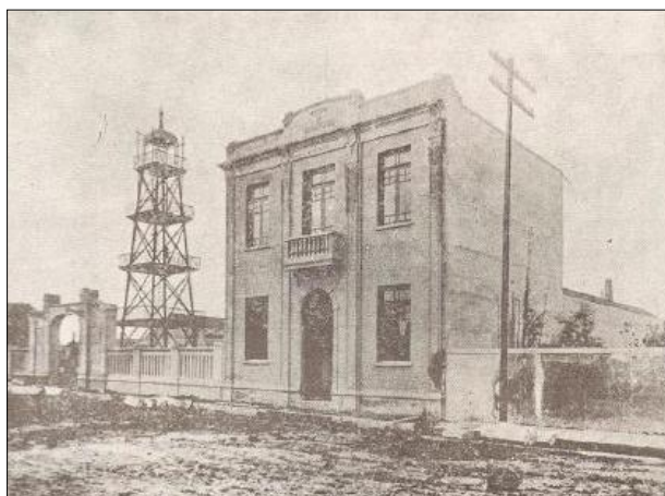
Figura 45: Estação do corpo de bombeiros, Pelotas, 1924. Fonte: MAGALHÃES, 1994, v.1, p.16.
