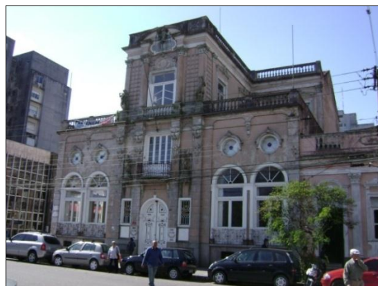
Figura 160: Sede do Clube Social Caixeiral, fachada principal, Pelotas, 2010. Fonte: Foto do autor.
