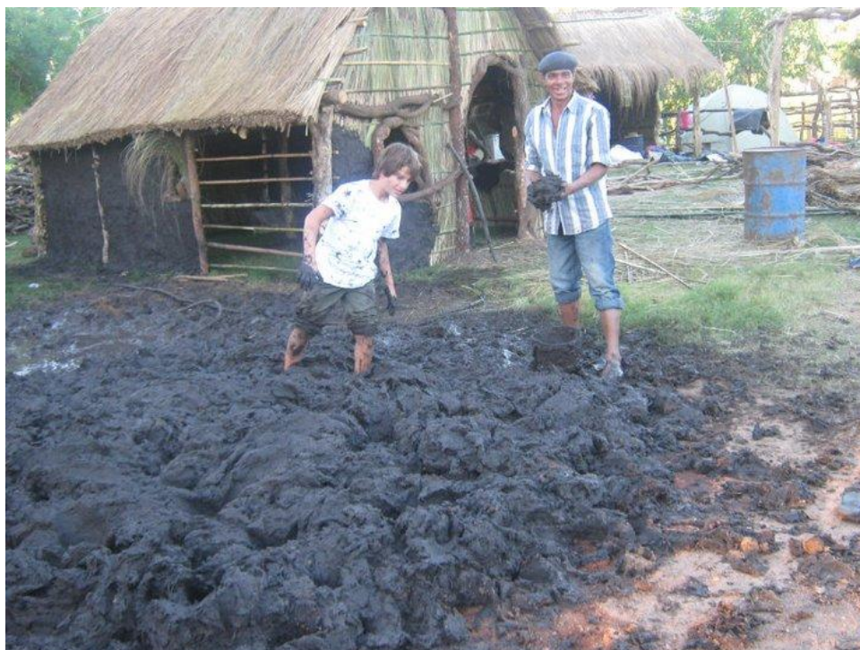
Construção das casas de barro. Patria Gaucha 2012 - Tacuarembó
