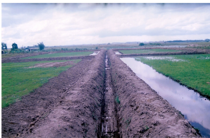
Figura 12: Primeira estrutura composta de 4 talhões de 30m x 45m, ao centro aparece o canal de drenagem, de cada lado as áreas de refúgio e nas extremidades direita e esquerda os canais de irrigação (Março/2004).
