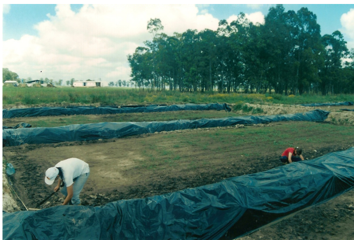
Figura 15: Revestindo as taipas das unidades experimentais com lona plástica preta reciclável (Maio/2004).
