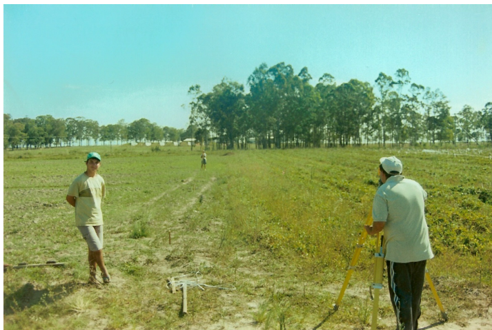
Figura 11: Levantamento altimétrico da área para determinação das cotas do terreno (Fevereiro/2004).
