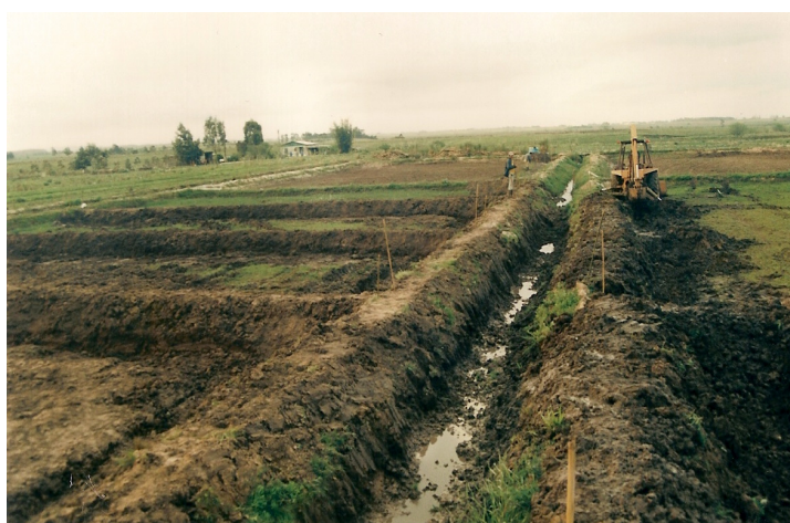
Figura 13: Construção de 16 unidades experimentais, cada unidade experimental composta de sistema de irrigação e drenagem individualizado (Abril/2004).
