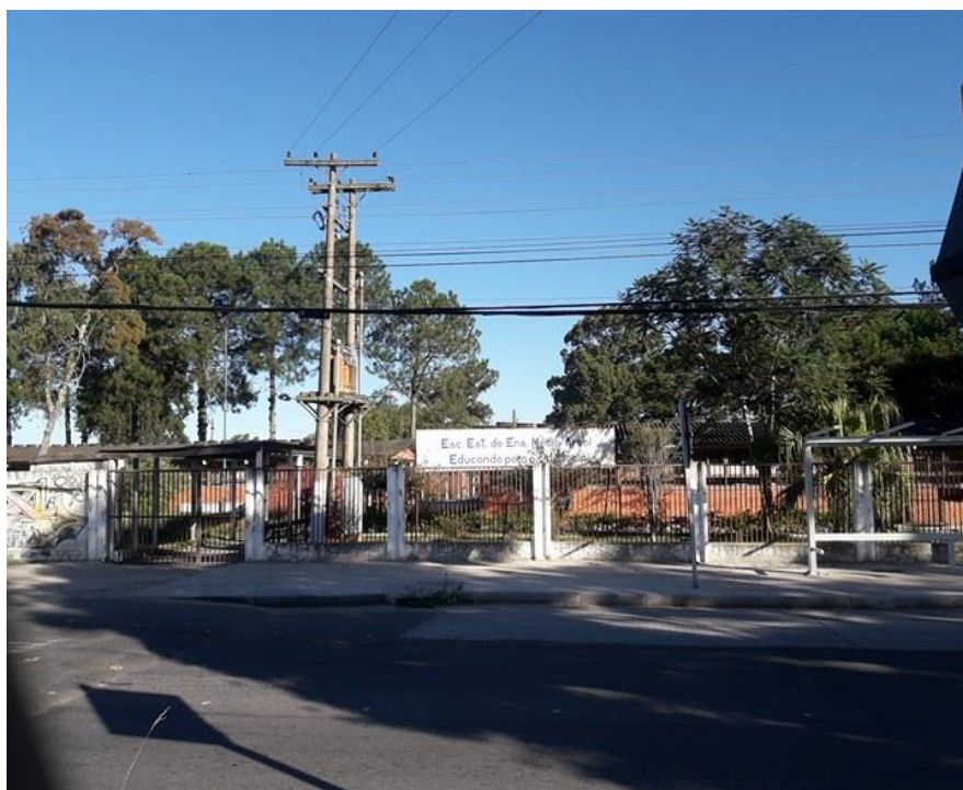
Figura 1: Faixada da Escola Estadual de Ensino Médio Areal. Fonte: Autora (2018).
