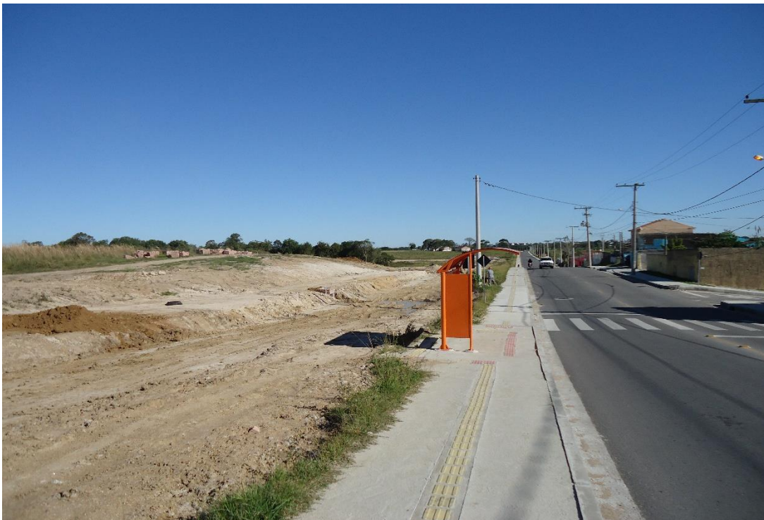
Figura 37- A Rua J.J. Bainy asfaltada em fevereiro de 2017
