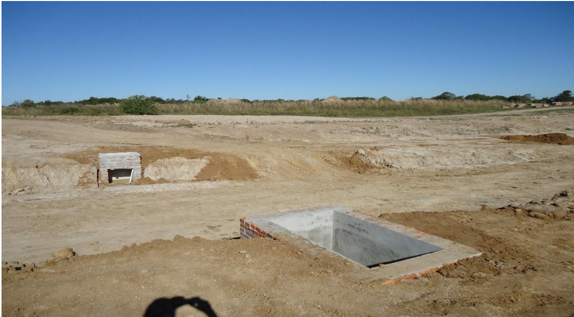
Figura 40- Terraplanagem e instalação de drenagem do novo bairro
