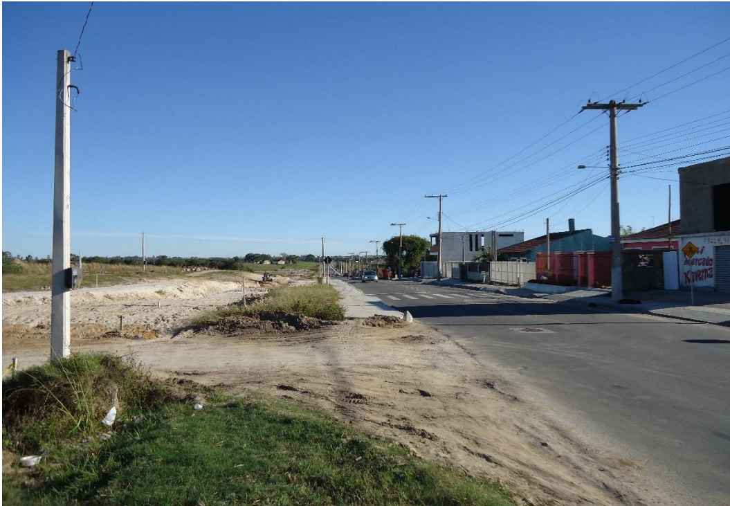
Figura 36- A Rua J.J. Bainy asfaltada em fevereiro de 2017
