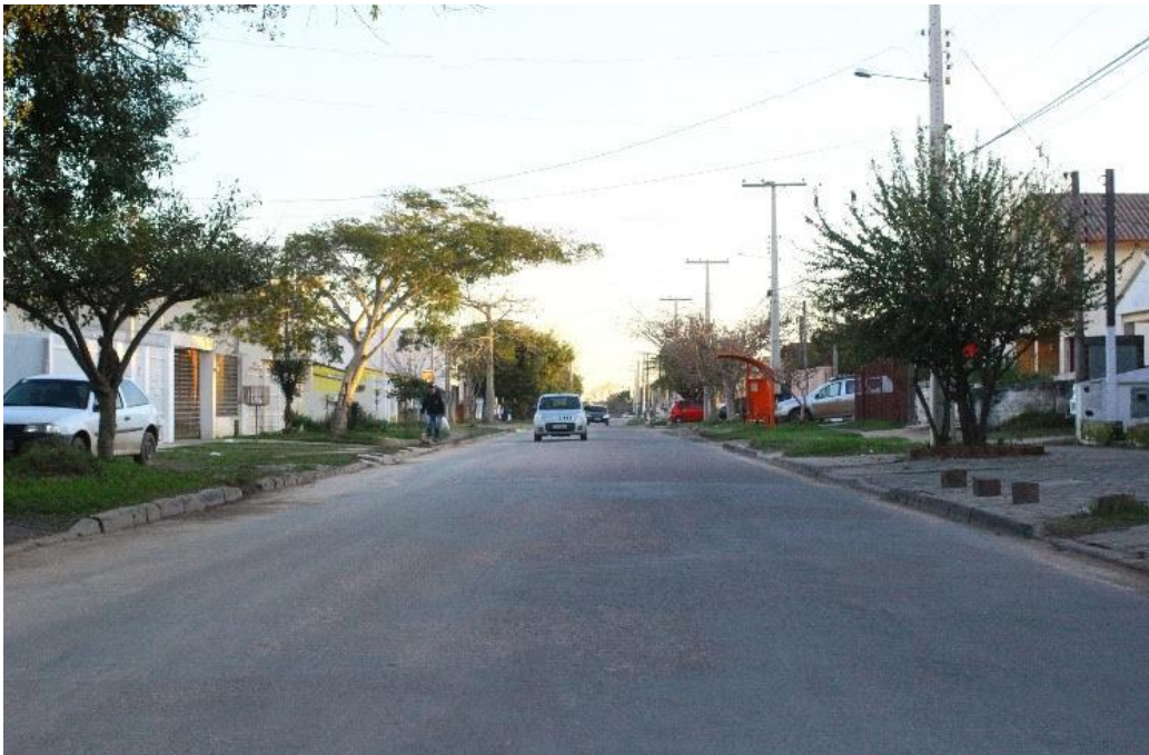
Figura 45- Rua João Jacob Bainy, já asfaltada
