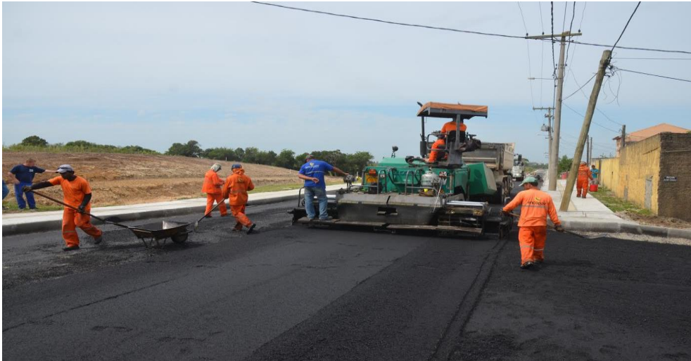
Figura 44- Serviço de Asfaltamento na rua João Jacób Bainy
