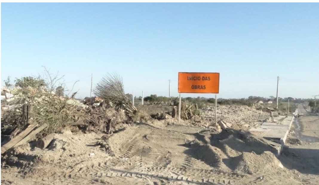
Figura 33- Terraplanagem do Quartier.
