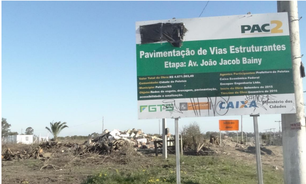
Figura 34- Placa do Governo Federal - Pavimentação da Rua João Jacob Bainy.
