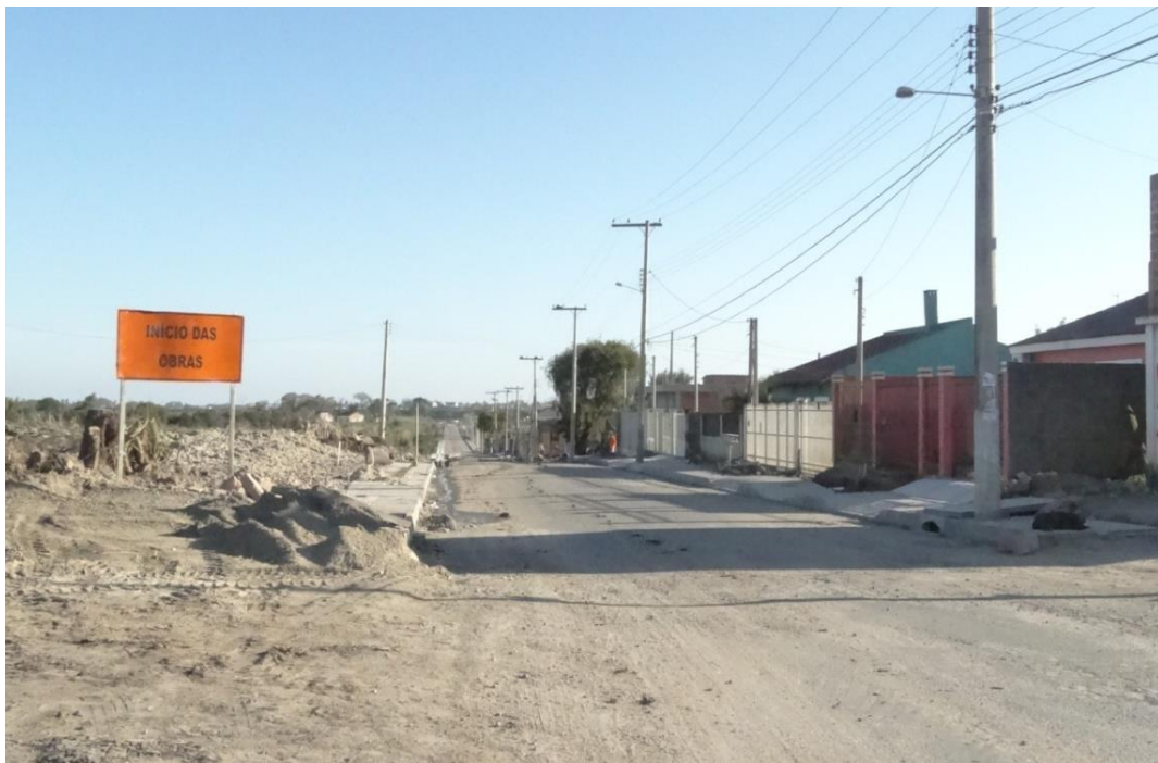
Figura 35- Pavimentação da Rua João Jacob Bainy.
