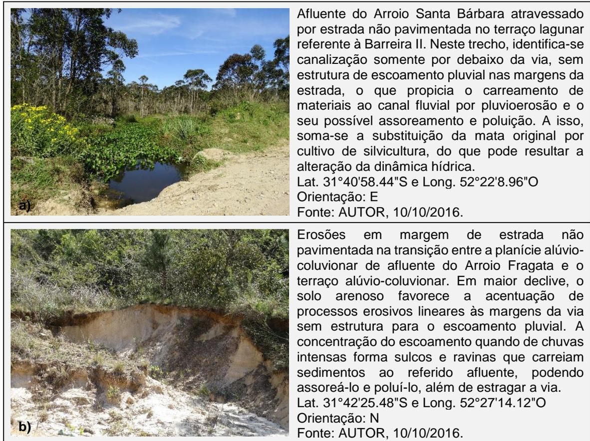
Figura 65 - (a, b) Registro e breve descrição de processos erosivos em estradas não pavimentadas.
