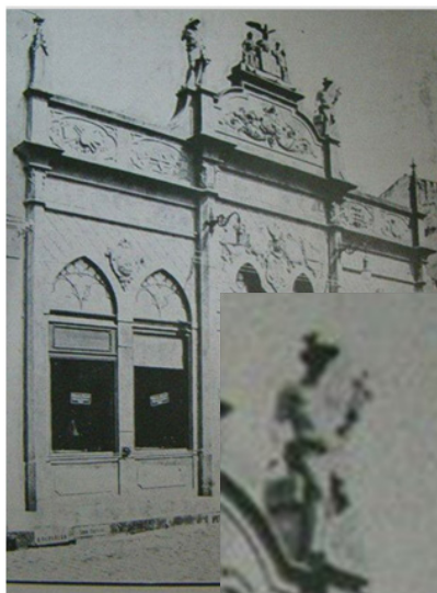
Figura 40 – Imagem e detalhe fachada Livraria Americana
