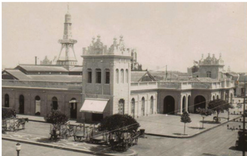
Figura 1 – Fotografia Mercado Público de Pelotas (aproximadamente 1920)
