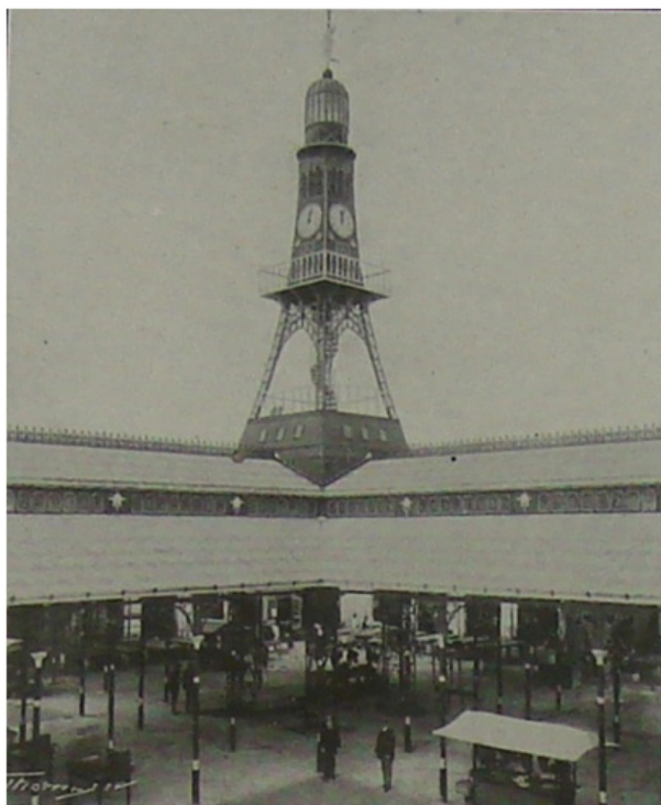
Figura 73 - Detalhe do Mercúrio instalado na torre. Fotografia de página de livro digitalizado
