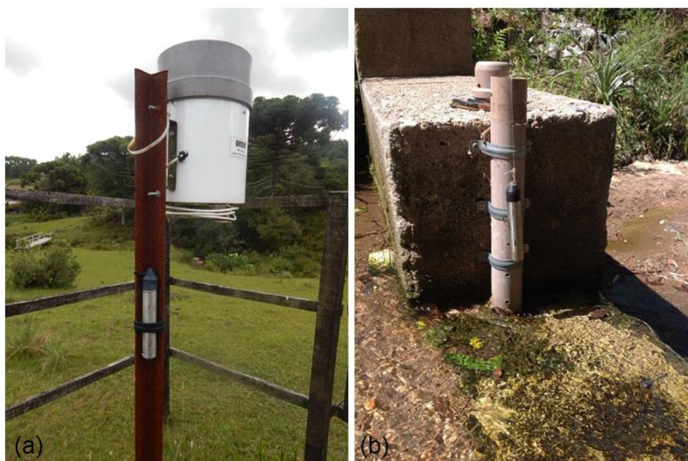
Figura 23 - Sensores de pressão instalados junto à estação pluviográfica (a) e sob a estrutura de concreto (b) da seção de controle da BHSE.
