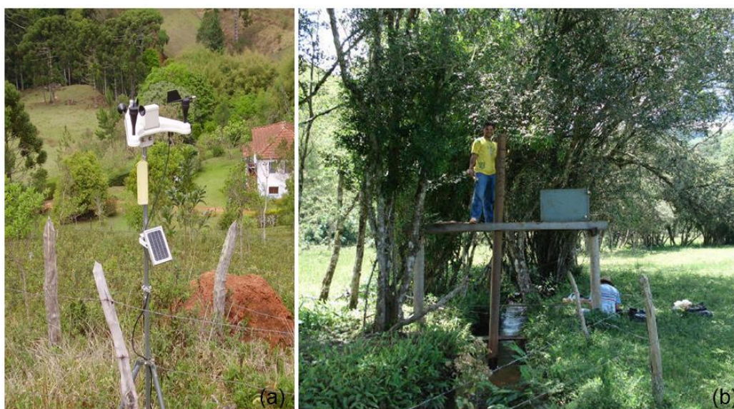
Figura 26 - Estação meteorológica instalada no município de Bocaina de Minas, Minas Gerais (a) e seção de controle da BHRL, com a estrutura para monitoramento automático de nível d'água e da unidade de aquisição e armazenamento das informações hidrológicas.
