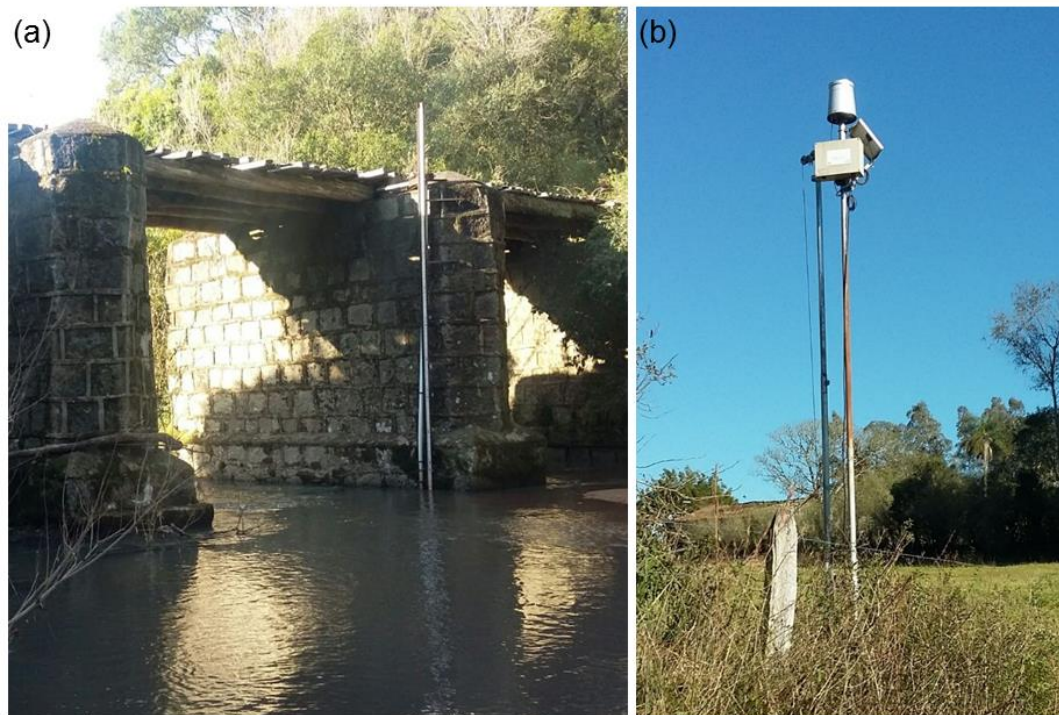
Figura 20 - Estrutura para monitoramento automático de nível d'água e réguas linimétricas (a) e, estação modelo Solar SL2000-PNVn, localizadas na seção de controle da BHAC (b).
