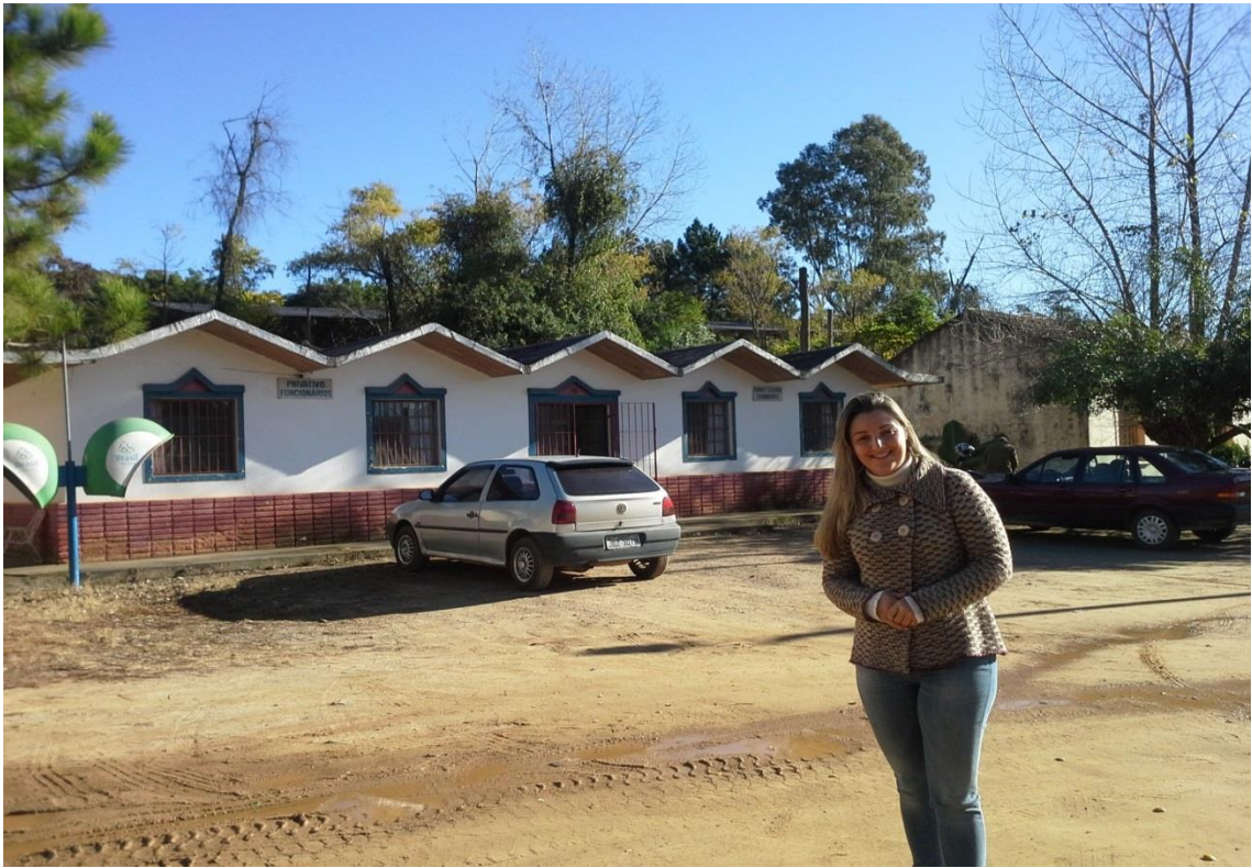
Figura 9 – Foto da Unidade de Saúde Colônia Maciel, município de Pelotas/RS, 2014 Fonte: Santos, 2014
