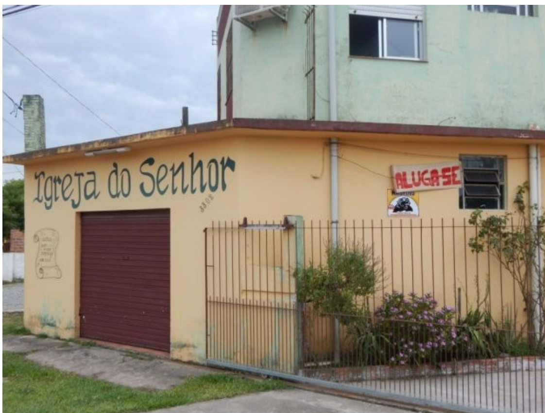
Figura 13 - Fachada de igreja (Igreja do Senhor). Fonte: do autor, 2017.
