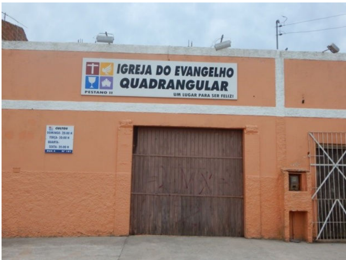
Figura 11 - Fachada de igreja (Igreja do Evangelho Quadrangular). Fonte: do autor, 2017.
