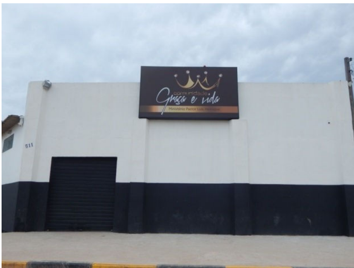
Figura 16 - Fachada de igreja (Igreja Graça e Vida).
