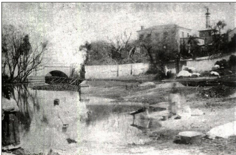
Figura 53: Obras de canalização do arroio (1881 ou 1882). Observa-se a presença de lavadeiras junto ao arroio e, ao fundo, Cervejaria Ritter. Fonte: Preterita Urbe.
