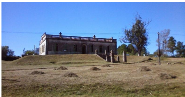
Figura 24 - Vista frontal do casarão na primeira vista da equipe na Usina de Cuñapirú. Foto: Taciane Souza, 2015.
