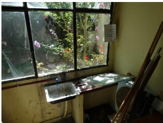
Figura 15 – Área com sistema hidráulico utilizada como depósito. Foto: Taciane Souza, 2015
