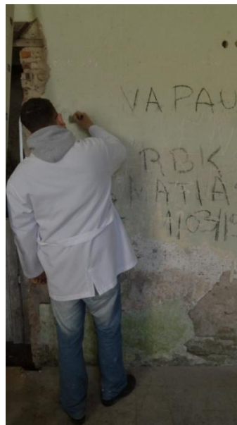
Figura 30 – O discente Eleri James Medeiros iniciando a higienização na parede P4, remoção das pichações utilizando pincéis e borrachas escolares. Foto: Jaime Mujica, 2015.
