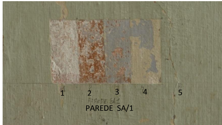
Figura 29 – Estudo das camadas de tinta na Sala A. Janela de prospecção de 3cm x 7cm (A x C) na parede P1. Foto: Taciane Souza, 2015.
