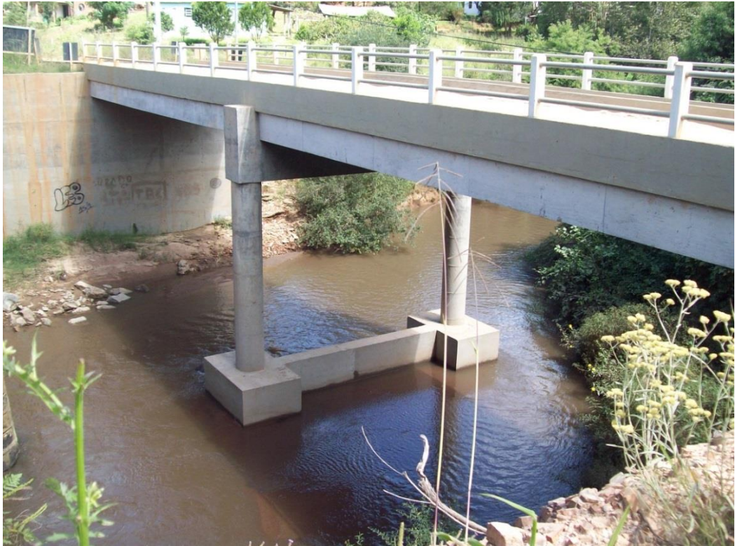
Figura 40: Ponte sobre o Arroio Quilombo – Bachini (Quilombo- 7º distrito de Pelotas) Fonte: RUTZ (2014)
