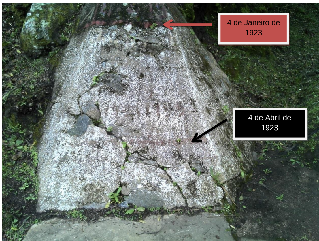
Figura 16: Registros das enchentes de 1923 em um fragmento rochoso na Represa do Quilombo Fonte: RUTZ (2014)
