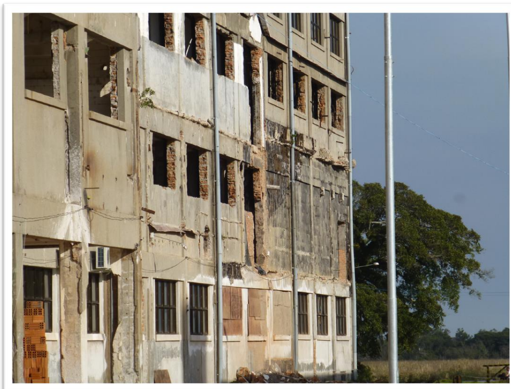
Prédio das câmaras frias, Pelotas, RS
