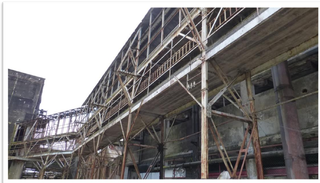
Figura 71 - Detalhe da passarela para as câmaras frias, Fray Bentos, Uruguay
