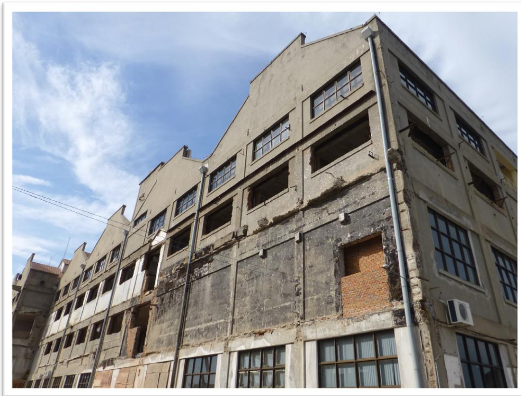
Prédio das câmaras frias, Pelotas, RS
