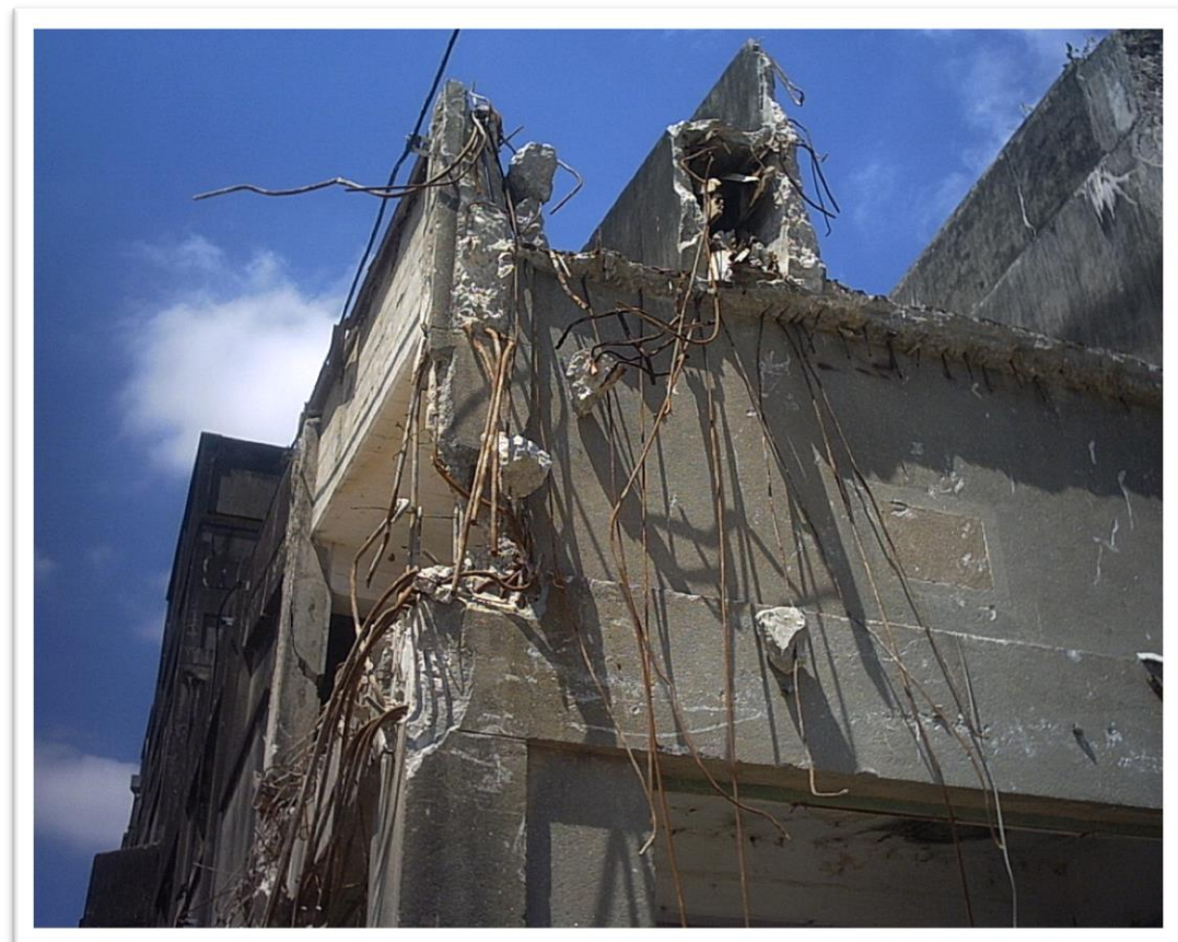
Figura 55 – Desmanche da rampa de acesso, Frigorífico Anglo de Pelotas, RS
