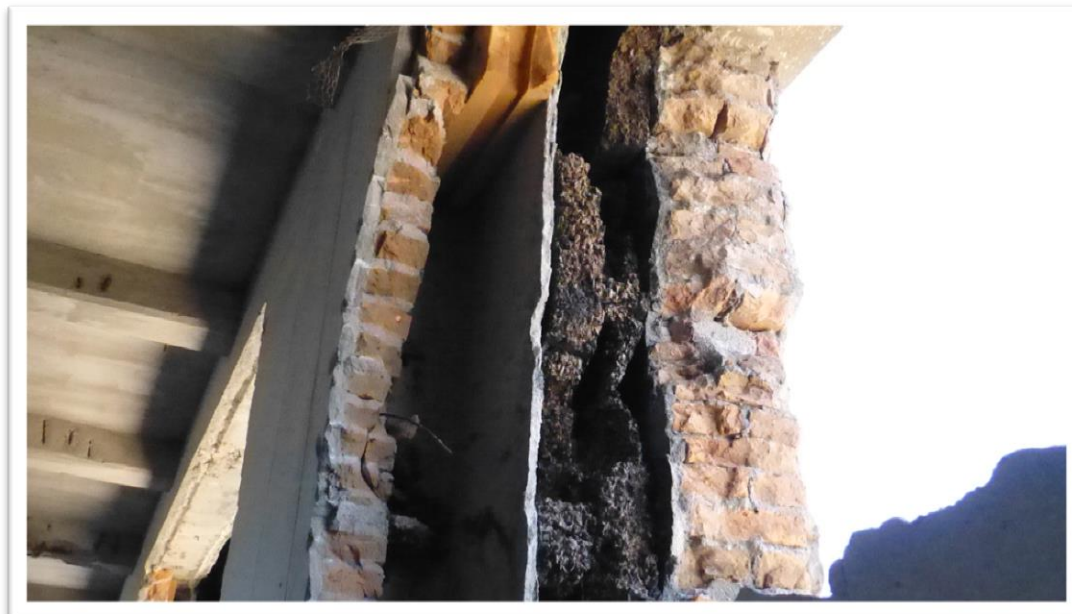
Figura 64 - Parede de uma câmara fria, Frigorífico Anglo de Pelotas, RS
