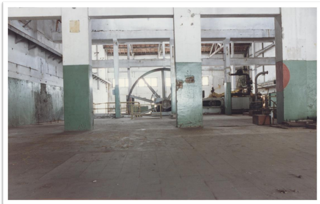
Figura 67 - Sala de máquinas, Frigorífico Anglo de Pelotas, RS
