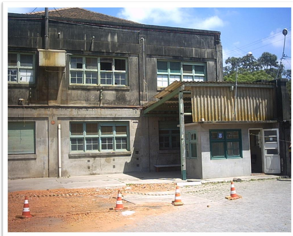
Figura 6 - Prédio da administração e laboratórios
