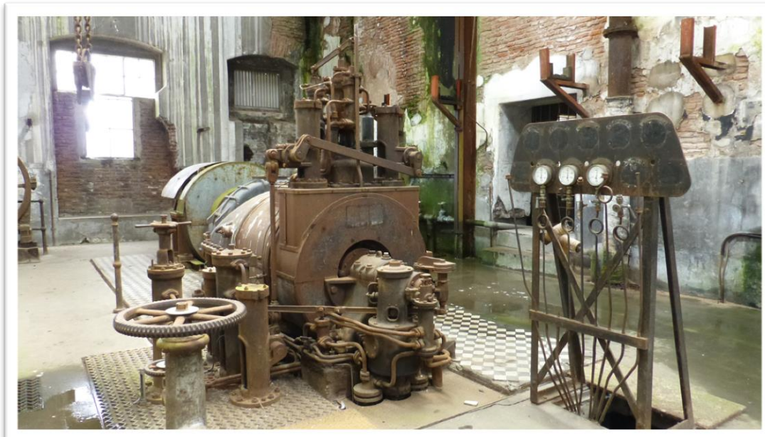
Geradores de energia, Fray Bentos, Uruguay
