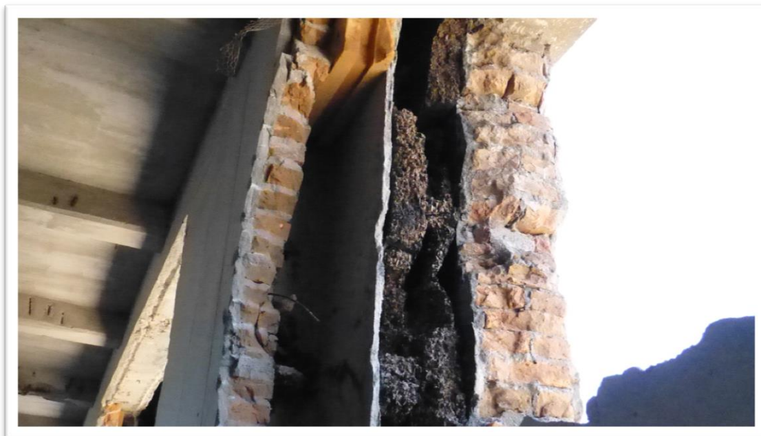
Figura 81 – Parede de uma câmara fria, Pelotas, RS
