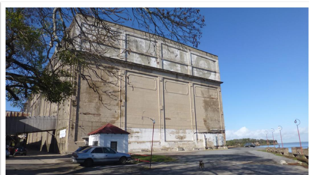
Figura 70 - Prédio das câmaras frias, Fray Bentos, Uruguay
