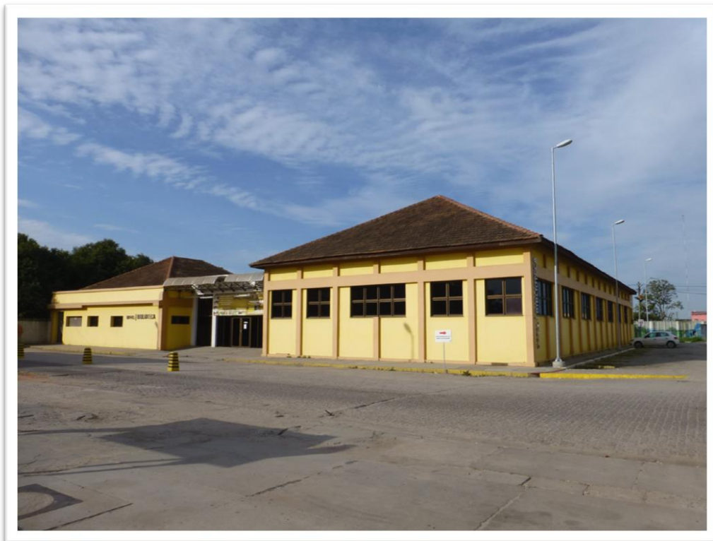
Figura 84 - Prédio da biblioteca do campus Anglo, Pelotas, RS
