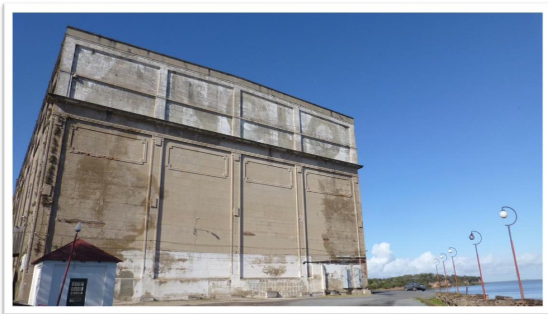
Figura 9 - Prédio das câmaras frias, Fray Bentos, Uruguay
