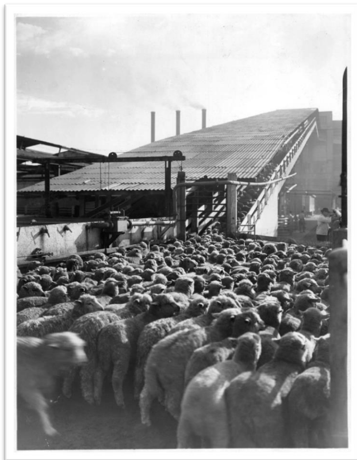
Ovinos subindo na rampa que as conduz na sala de abate, Frigorífico Anglo Dock Sud, Avellaneda, Argentina
