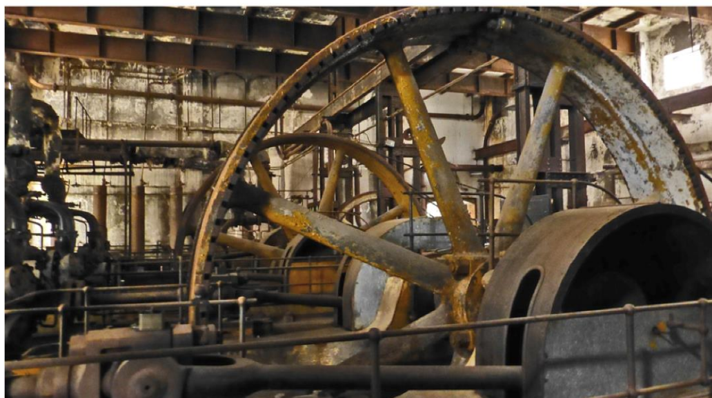
Sala de máquinas, Fray Bentos, Uruguay
