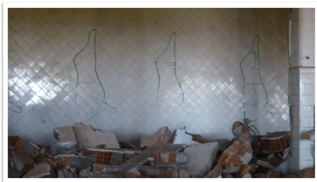
Figura 75 - Parede da câmara fria com azulejos, Pelotas, RS
