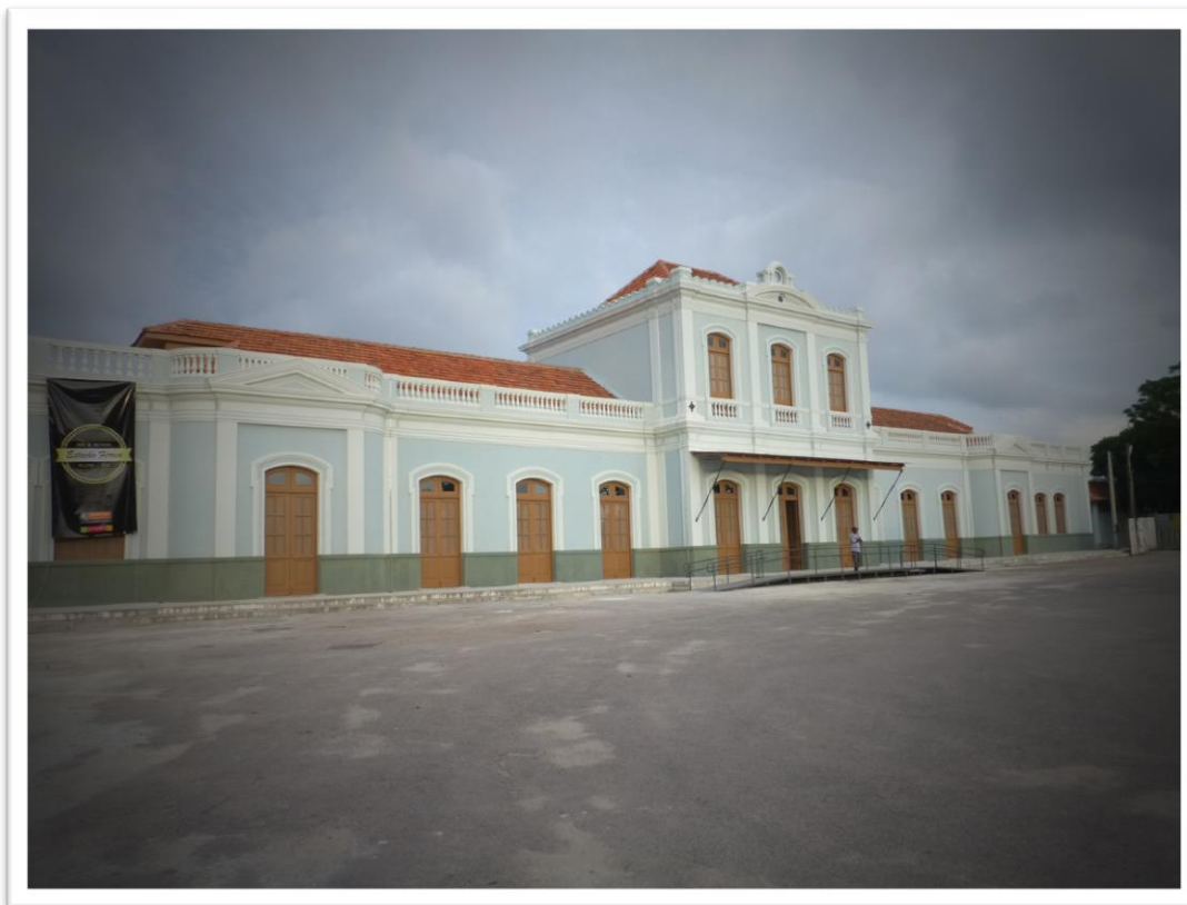
Estação ferroviária de Pelotas, RS
