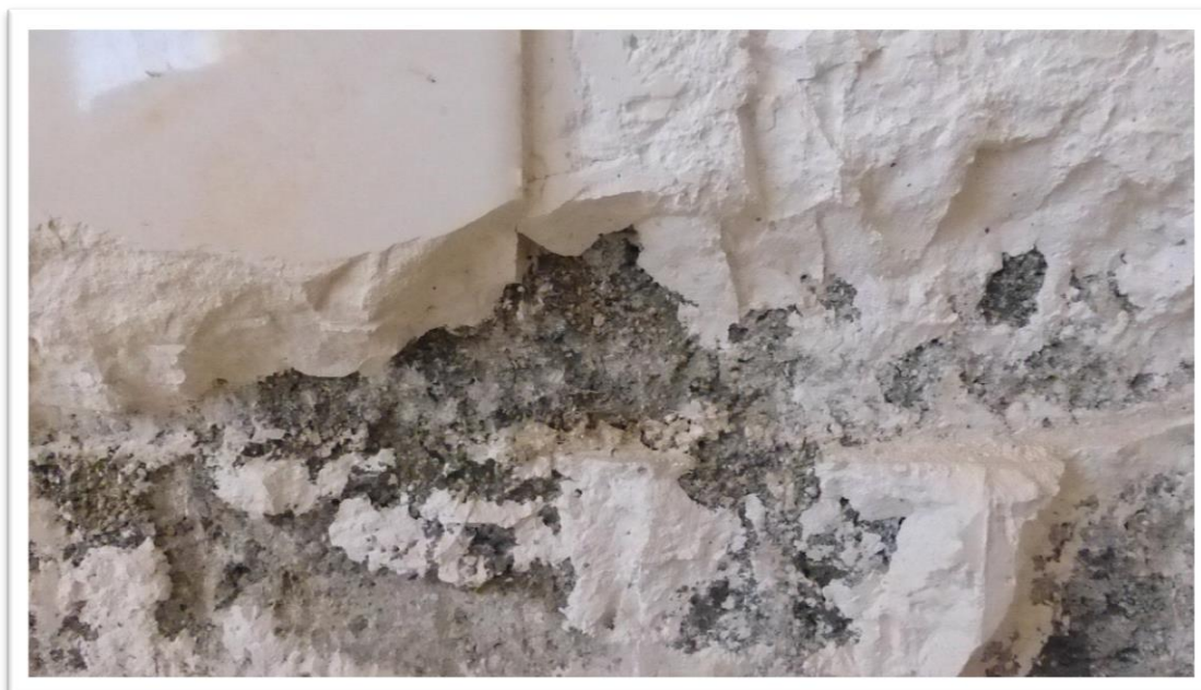
Figura 76 - Azulejos sendo removidos, Pelotas, RS
