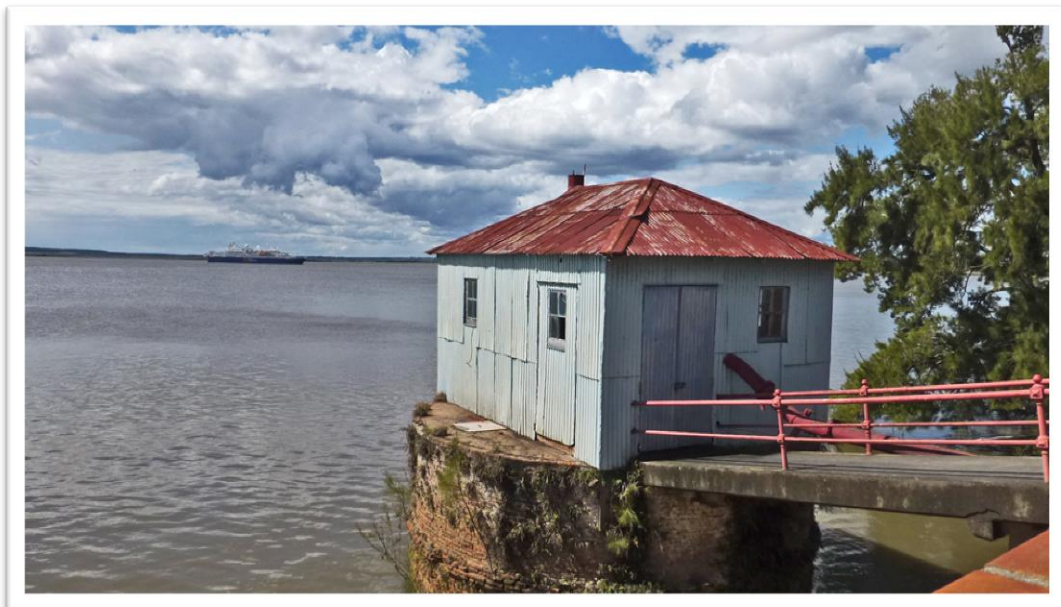
Bomba de incêndio, Fray Bentos, Uruguay
