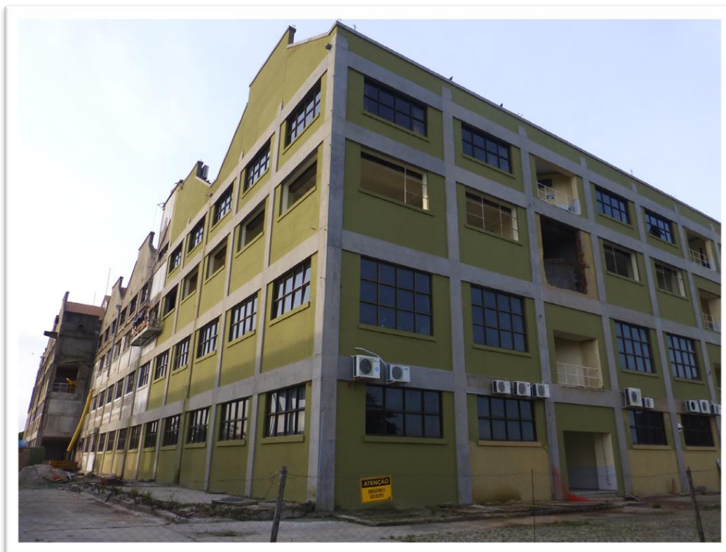
Figura 85 - Bloco A recebendo pintura, Pelotas, RS
