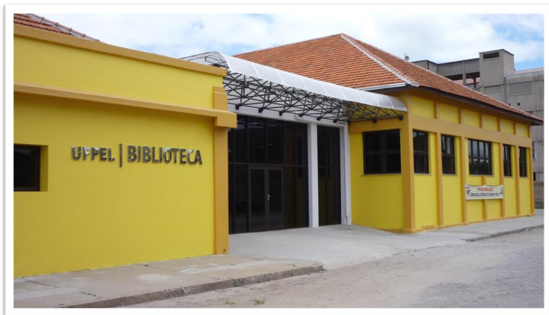
Figura 8 - Prédio da biblioteca do Campus Anglo, Pelotas, RS
