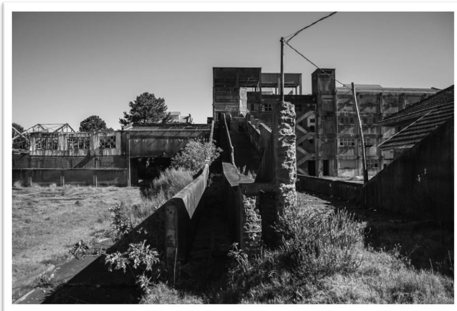
Vista da rampa de acesso antes da destruição, Pelotas, RS
