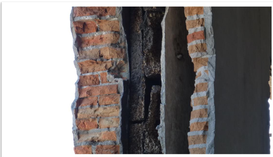
Figura 19 – Detalhe de uma parede das câmaras frias, Frigorífico Anglo de Pelotas, RS
