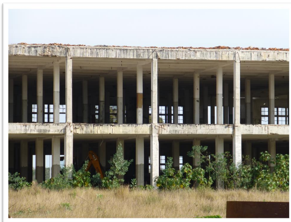
Figura 51 - Situação atual do Frigorífico Anglo de Pelotas, Pelotas, RS
