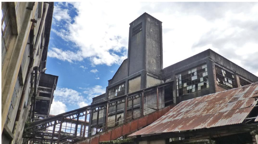
Prédio da matança e processamento da carne, Fray Bentos, Uruguay
