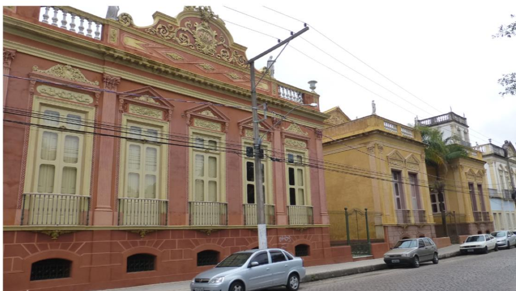
Museu do Doce e conjunto arquitetônico da praça Cel. Pedro Osório, Pelotas, RS
