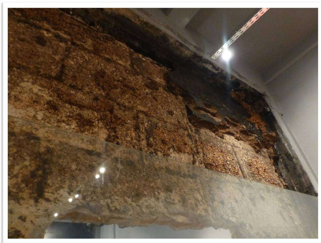
Figura 20 – Mostra da parede da câmara fria no Memorial do Anglo de Pelotas, RS
