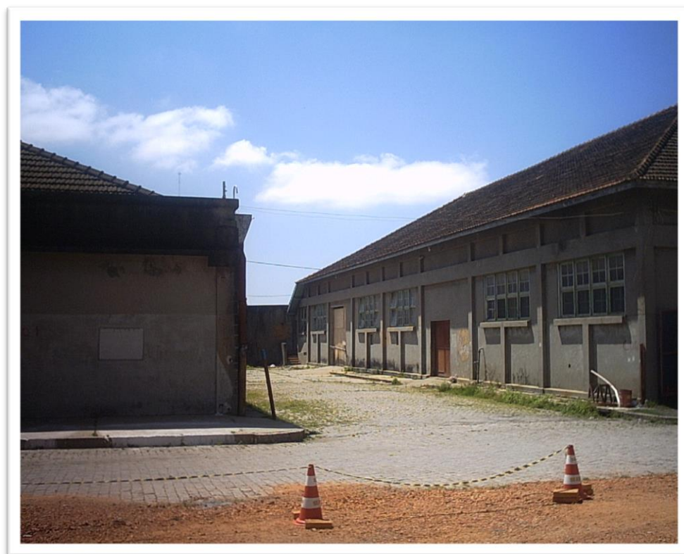
Figura 7 - Casa de força e lavanderia
