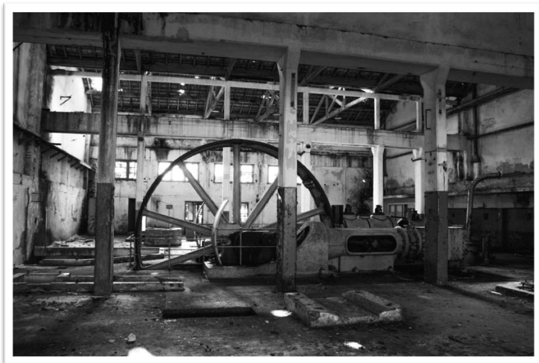
Figura 68 - Sala de máquinas, Frigorífico Anglo de Pelotas, RS
