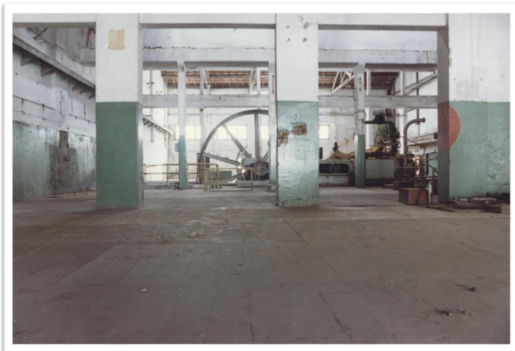
Sala de máquinas, Pelotas, RS
