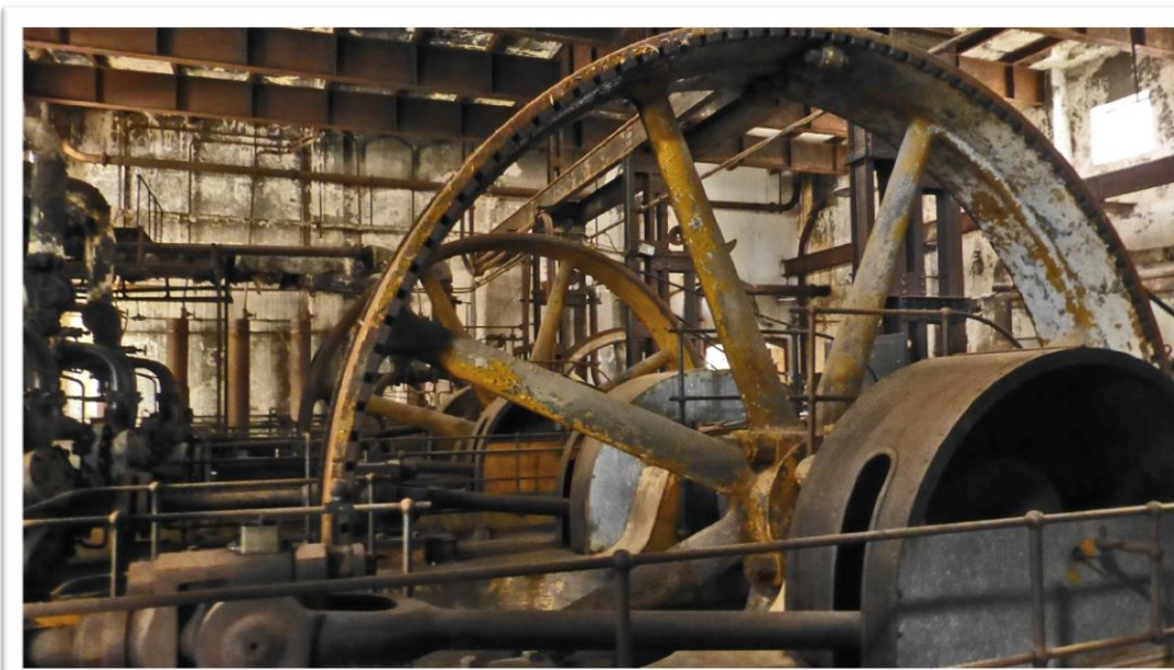
Figura 66 - Sala de máquinas, Frigorífico Anglo del Uruguay, Fray Bentos
