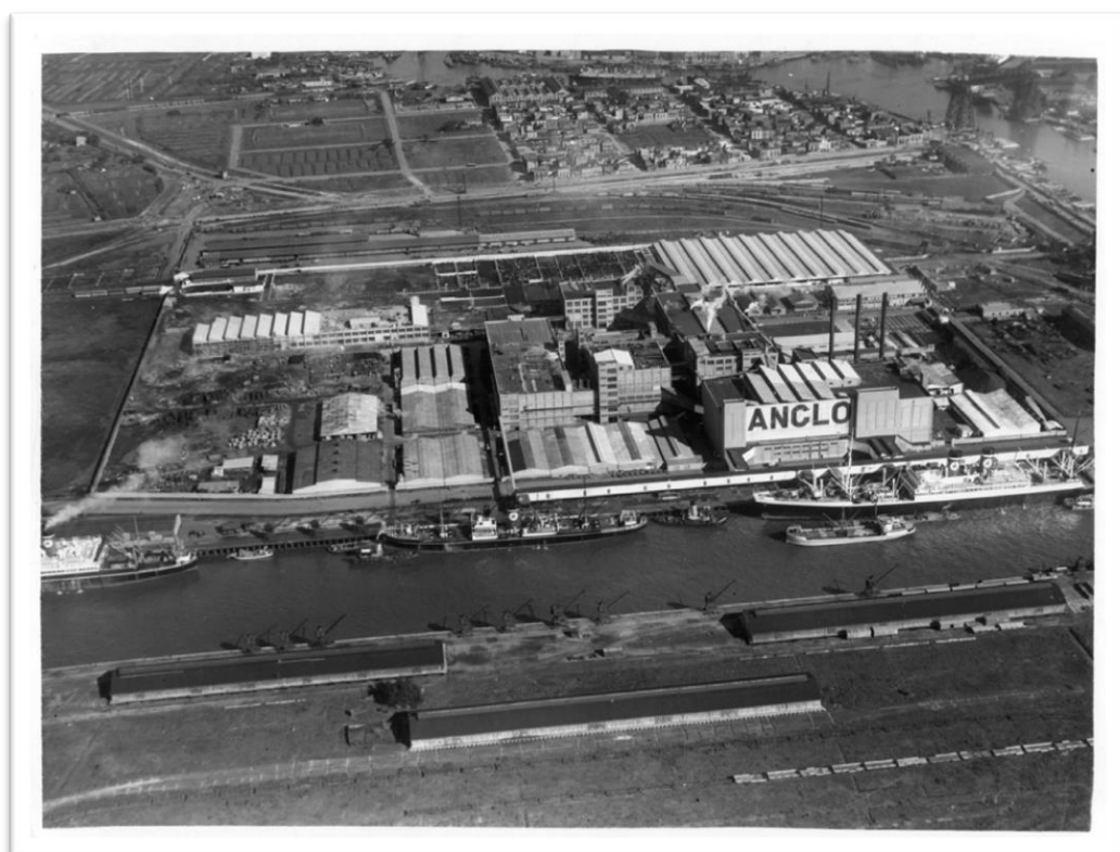
Frigorífico Anglo, Dock Sud, Avellaneda, Argentina
