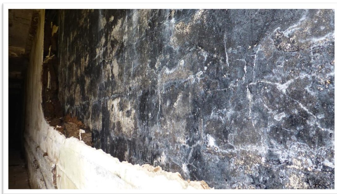
Figura 21 – Parede interna mostrando o revestimento, Frigorífico Anglo del Uruguay, Fray Bentos
