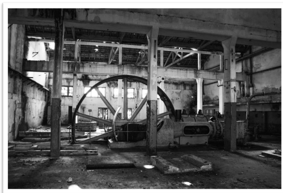
Sala de máquinas, Pelotas, RS
