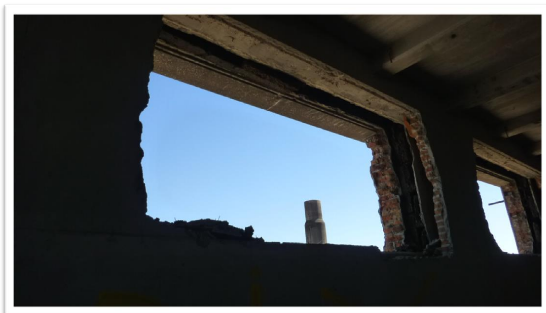
Janelas abertas na parede cega das câmaras frias, Pelotas, RS
