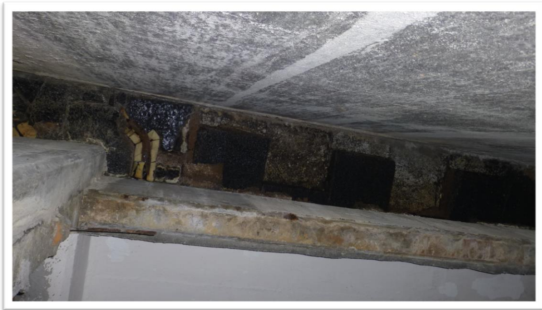
Figura 15 – Tubulações de amônia, Frigorífico Anglo de Pelotas, RS
