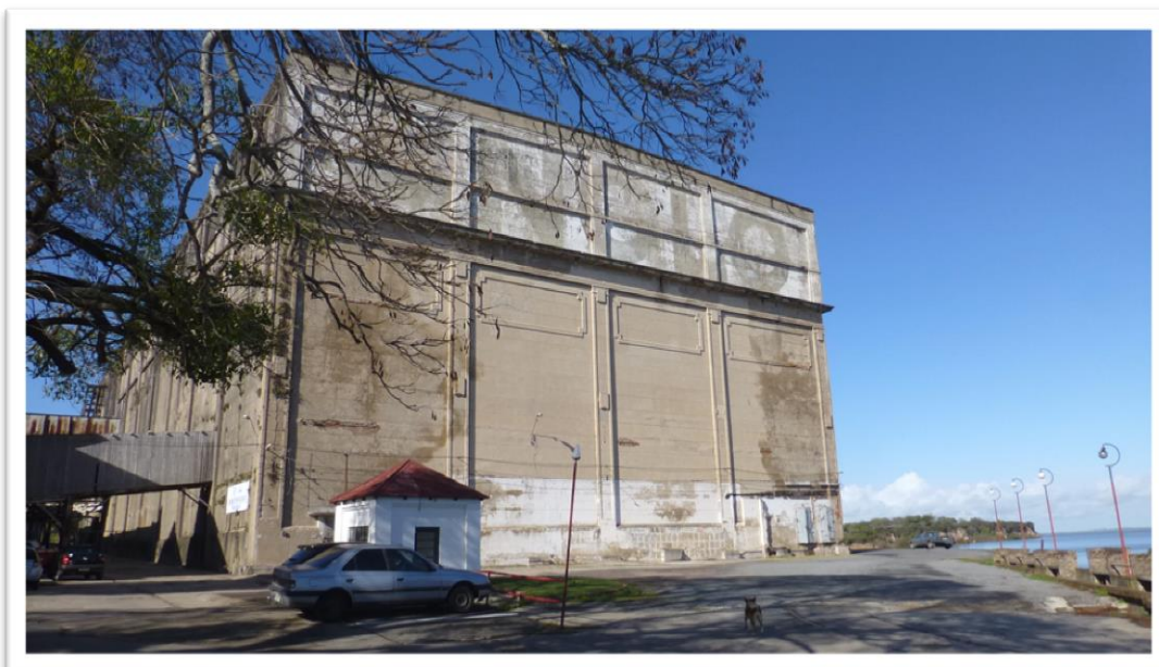
Figura 58 - Frigorífico Anglo del Uruguay, prédio das câmaras frias, Fray Bentos, Uruguay
