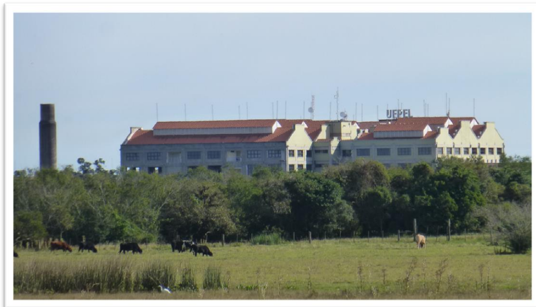
Figura 46 - Prédios do extinto Frigorífico Anglo, após ocupação pela UFPel, Pelotas, RS
