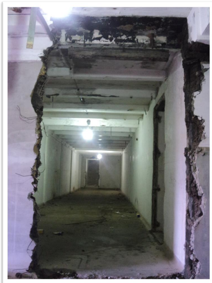
Figura 83 – Câmara fria ainda preservada, Frigorífico Anglo de Pelotas, RS
