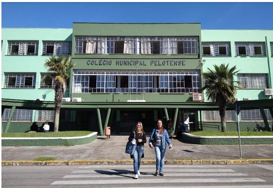
Figura 5: Fachada do CMP
