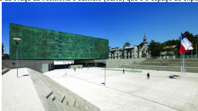
Figura 14: Fotografia da Praça da Memória e edifício (barra) que é o espaço de expografia do MMDH
