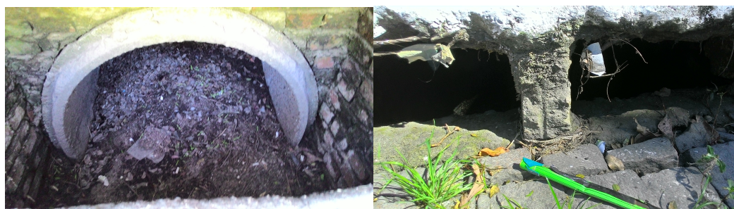
A: Sedimentos na entrada de uma Galeria.
