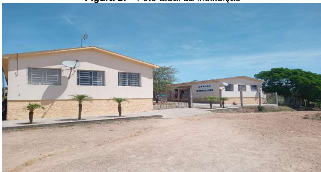
Figura 17 - Foto atual da Instituição
